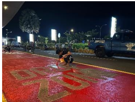
Gambar 4.33 Pengecatan tepi marka dengan kuas
