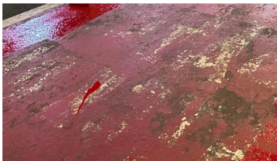
Gambar 4.15 Kondisi saat ini marka drop zone
