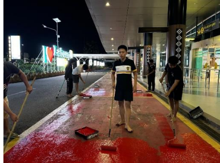
Gambar 4.34 Pengecatan blok atau isi dengan rol
