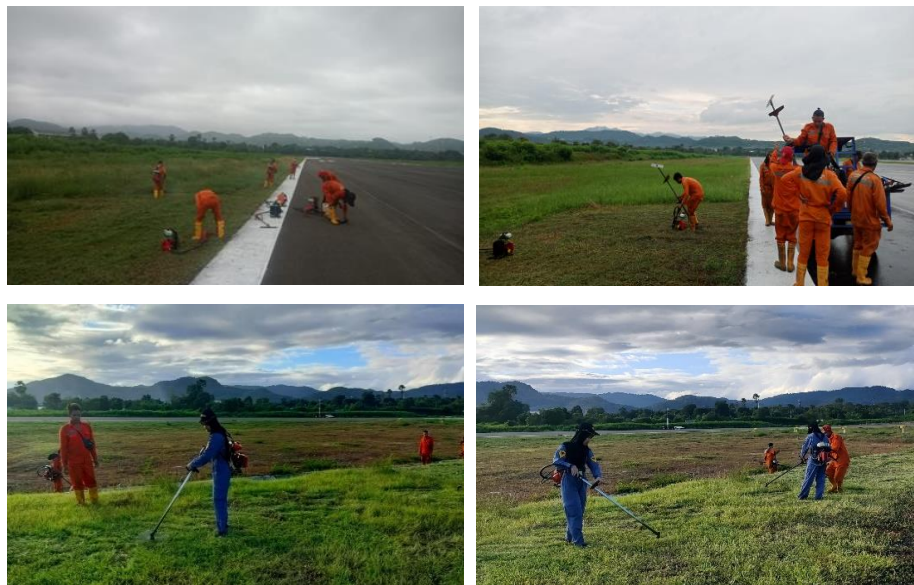
Gambar 4.20 Pekerjaan pemeliharaan runway strip
