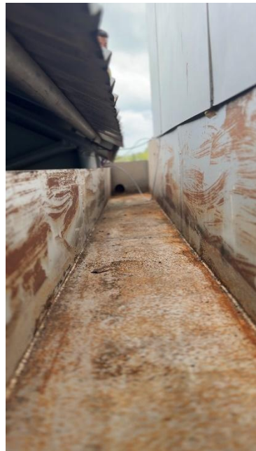
Gambar 4.84 Hasil Pekerjaan Perawatan Talang Air Baja Ringan
