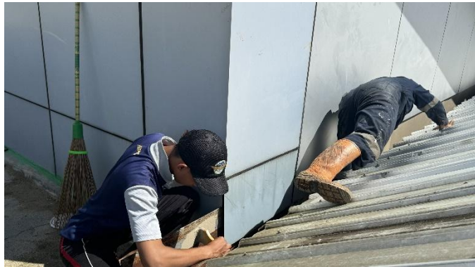
Gambar 4.75 Proses Perawatan Talang Air Baja Ringan
