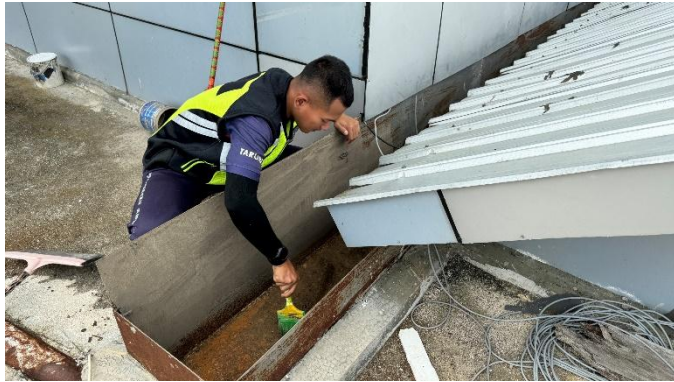
Gambar 4.81 Proses Perawatan Talang Air Baja Ringan
