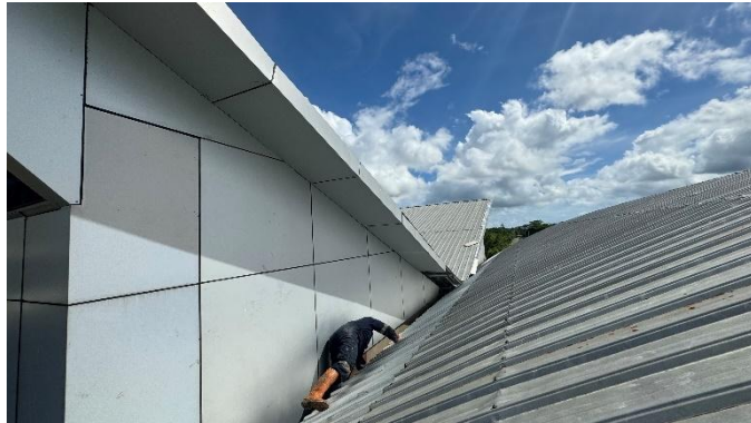
Gambar 4.74 Proses Perawatan Talang Air Baja Ringan
