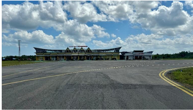
Gambar 4.1 Gedung Terminal Lama dan Baru
