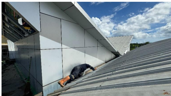
Gambar 4.76 Proses Perawatan Talang Air Baja Ringan
