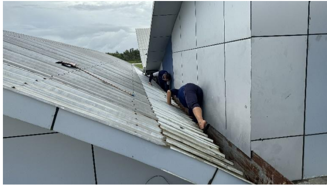
Gambar 4.77 Proses Perawatan Talang Air Baja Ringan
