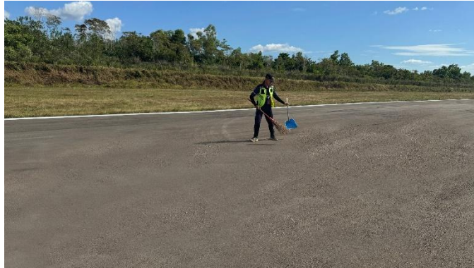
Gambar 4.56 Pembersihan Permukaan Runway
