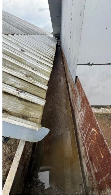
Gambar 4.85 Hasil Pekerjaan Perawatan Talang Air Baja Ringan
