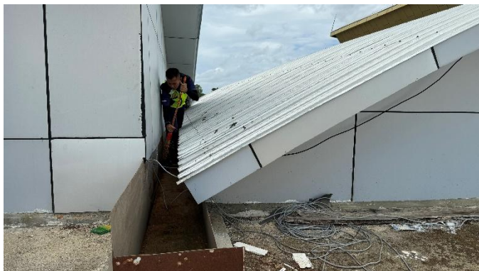
Gambar 4. 82 Proses Perawatan Talang Air Baja Ringan
