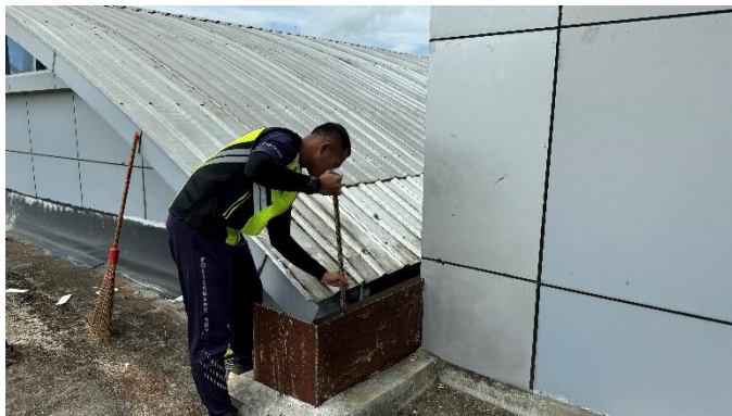
Gambar 4.83 Proses Perawatan Talang Air Baja Ringan
