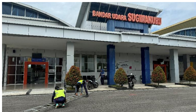
Gambar 4.79 Proses Perawatan Talang Air Baja Ringan
