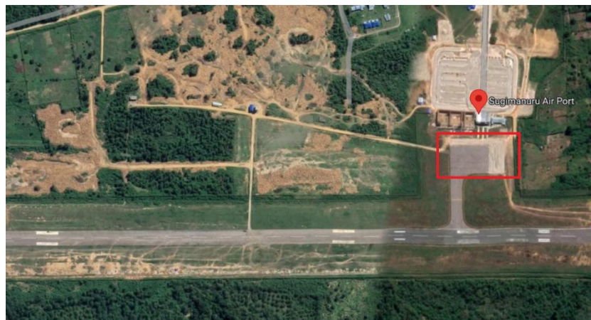
Gambar 4.30 Apron Bandar Udara Sugimanuru
