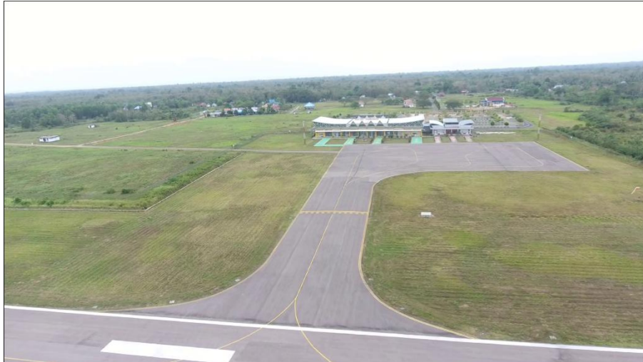
Gambar 4.28 Taxiway Bandar Udara Sugimanuru
