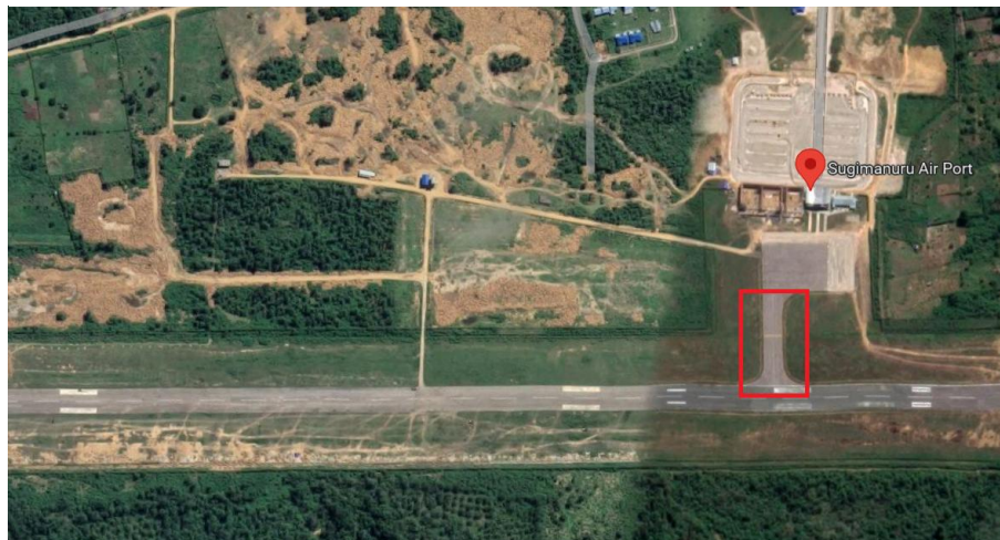
Gambar 4.29 Taxiway Bandar Udara Sugimanuru
