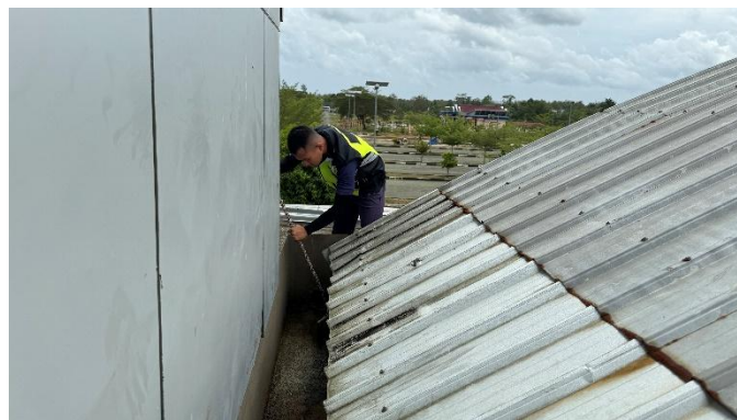
Gambar 4.80 Proses Perawatan Talang Air Baja Ringan
