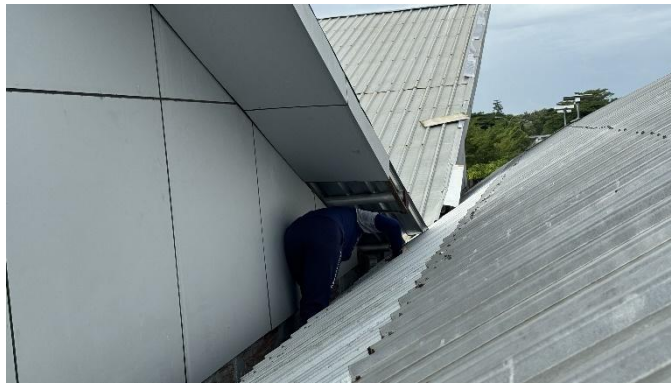
Gambar 4.78 Proses Perawatan Talang Air Baja Ringan
