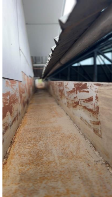
Gambar 4.86 Hasil Pekerjaan Perawatan Talang Air Baja Ringan
