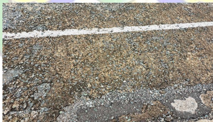
Gambar 4. 6 Paving mengelupas
