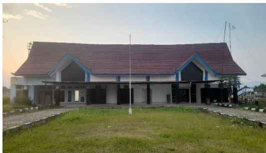
Gambar 4.9 Gedung AirNav Bandara Atung Bungsu
