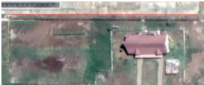
Gambar 4.15 Jalan Service Road Di Depan Gedung Airnav Bandar Udara Atung Bungsu
