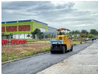
Gambar 4.34 Proses Pemadatan Akhir
