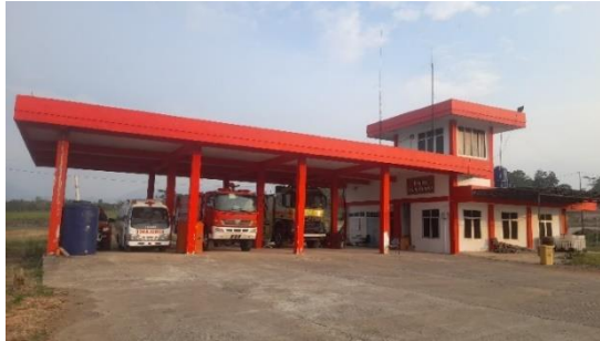
Gambar 4.8 Gedung PKP-PK Bandara Atung Bungsu
