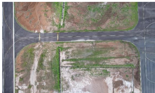
Gambar 4.14 Taxiway Bandar Udara Atung Bungsu
