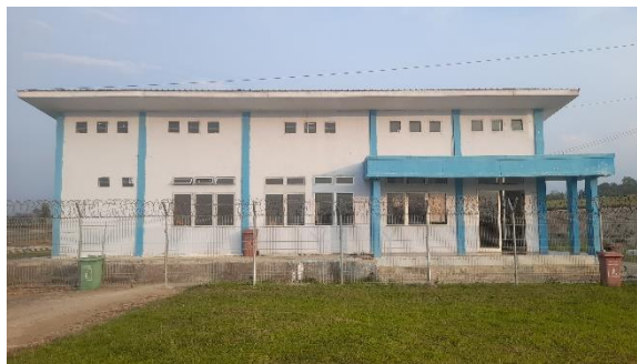
Gambar 4.7 Gedung Bangunan dan Landasan Bandar Udara Atung Bungsu (Sumber : Dokumentasi Penulis, 2025)
