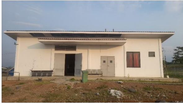
Gambar 4.10 Gedung Power House Bandara Atung Bungsu (Sumber : Dokumentasi Penulis, 2025)
