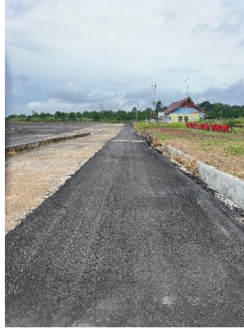
Gambar 4.35 Kondisi Jalan Service Road Di Depan Gedung Airnav Setelah Pembuatan Perkerasan Baru
