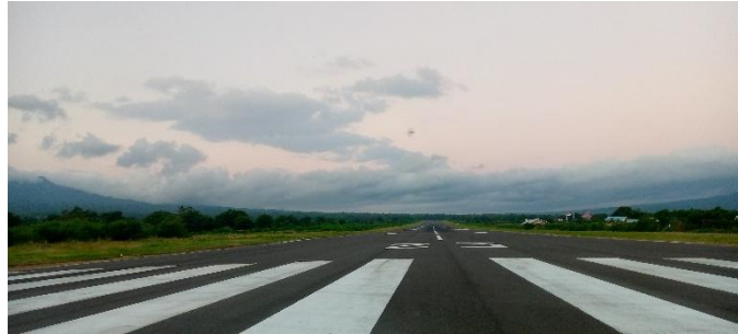
Gambar 4.15 Kondisi runway sebelum overlay (Sumber : Dokumentasi Penulis)
