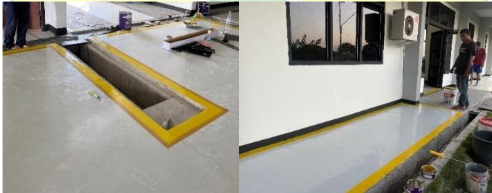
Gambar 4.69 Lapisan Kedua Epoksi (Sumber : Dokumentasi Penulis)
