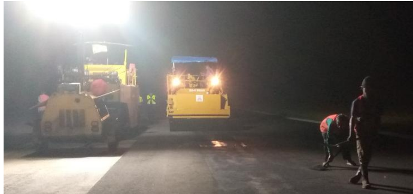
Gambar 4.50 Pemadatan Tandem Roller (Sumber : Dokumentasi Penulis)
