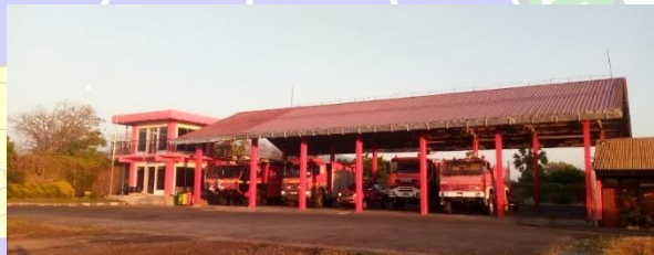
Gambar 4.6 Gedung PKP-PK Bandar Udara Frans Seda (Sumber : Dokumentasi Penulis)
