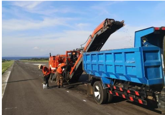
Gambar 4.45 Proses Cold Milling (Sumber : Dokumentasi Penulis)
