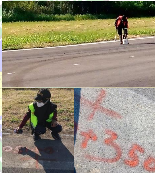
Gambar 4.44 Proses Marking (Sumber : Dokumentasi Penulis)
