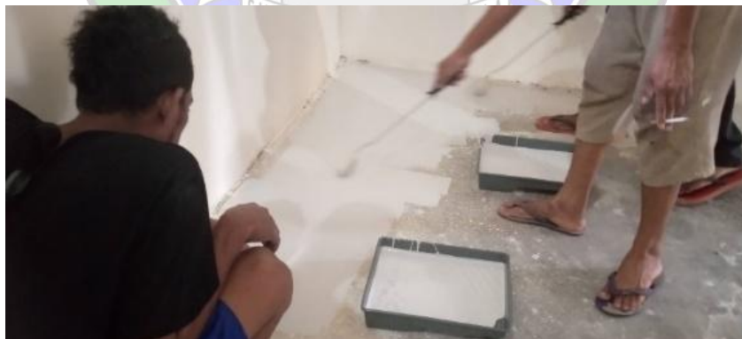
Gambar 4.67 Proses Priming Epoksi (Sumber : Dokumentasi Penulis)
