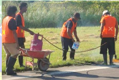
Gambar 4.30 Heating torch gas LPG (Sumber : Dokumentasi Penulis)
