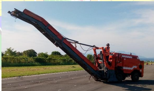
Gambar 4.22 Cold Milling (Sumber : Dokumentasi Penulis)
