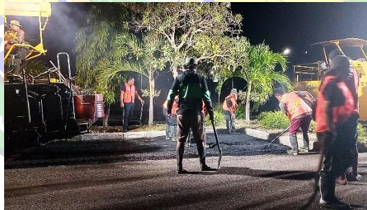
Gambar 4.43 Trial Compaction di Area Parkir (Sumber : Dokumentasi Penulis)
