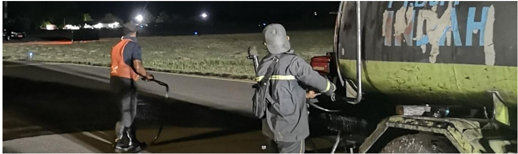
Gambar 4.23 Asphalt Sprayer (Sumber : Dokumentasi Penulis)
