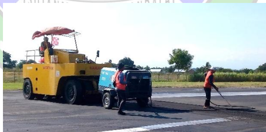
Gambar 4.55 Pembersihan dengan Air Compressor (Sumber : Dokumentasi Penulis)
