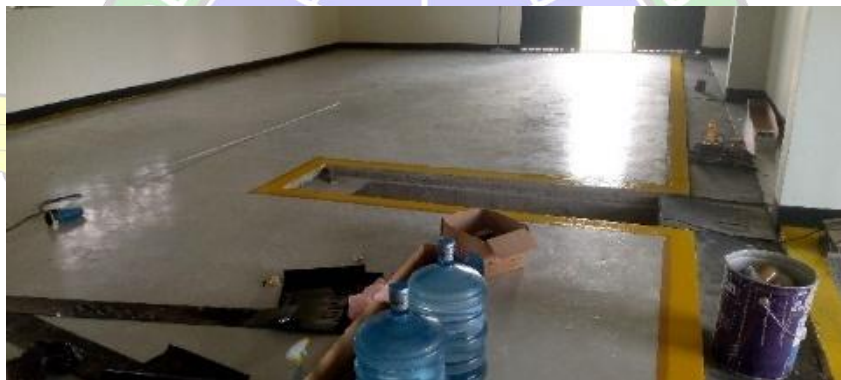
Gambar 4.71 Lantai Gedung Powerhouse setelah Epoksi (Sumber : Dokumentasi Penulis)
