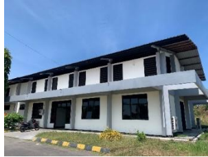
Gambar 4.5 Gedung Powerhouse Bandara Frans Seda (Sumber : Dokumentasi Penulis)
