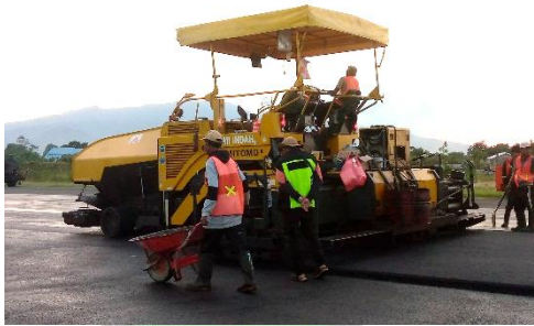
Gambar 4.19 Finisher Aspal (Sumber : Dokumentasi Penulis)
