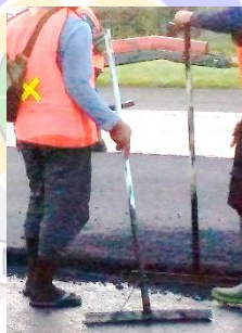
Gambar 4.28 Garu (Sumber : Dokumentasi Penulis)
