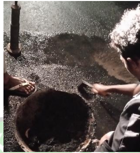
Gambar 4.54 Penambalan Lubang Core Drill (Sumber : Dokumentasi Penulis)
