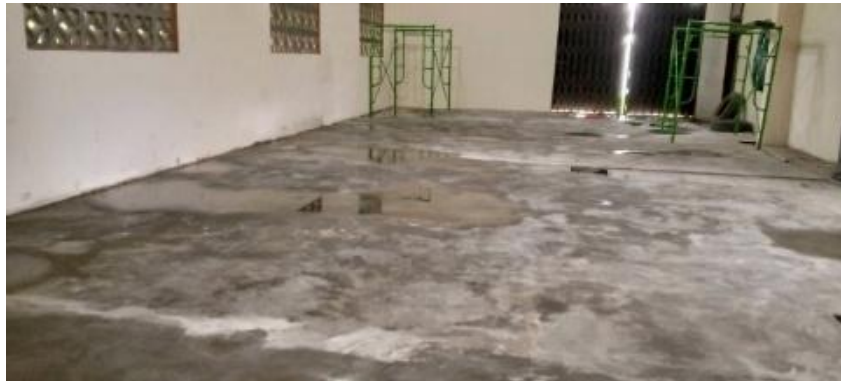
Gambar 4.70 Lantai Gedung Powerhouse sebelum Epoksi (Sumber : Dokumentasi Penulis)
