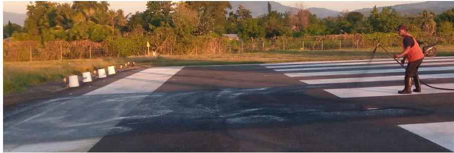
Gambar 4.47 Proses Tack Coat (Sumber : Dokumentasi Penulis)
