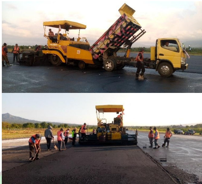
Gambar 4.48 Proses Hampar Aspal (Sumber : Dokumentasi Penulis)
