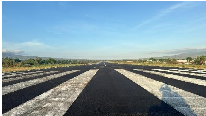
Gambar 4.56 Kondisi Landasan setelah Overlay (Sumber : Dokumentasi Penulis)
