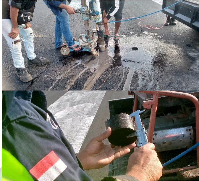
Gambar 4.52 Pengambilan Sampel Core Drill (Sumber : Dokumentasi Penulis)
