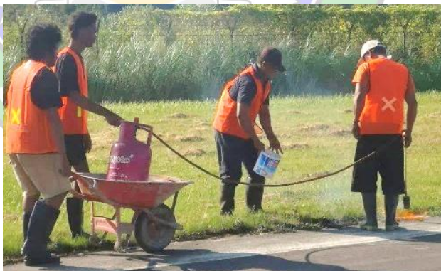
Gambar 4.46 Pembersihan dengan Heating Torch Gas LPG (Sumber : Dokumentasi Penulis)
