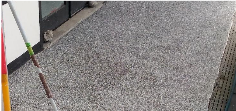
Gambar 4.68 Epoksi Flakes yang telah ditabur (Sumber : Dokumentasi Penulis)
