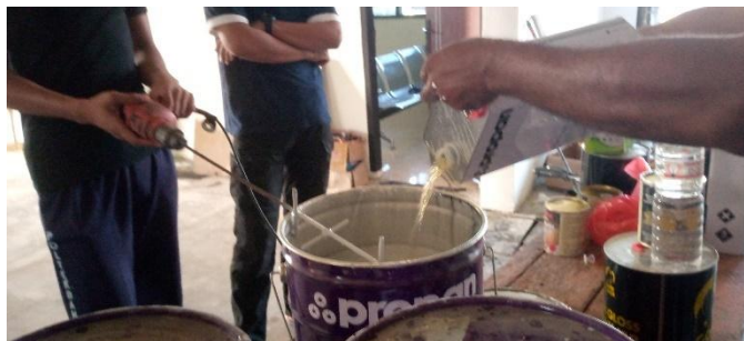
Gambar 4.66 Pencampuran Epoksi (Sumber : Dokumentasi Penulis)
