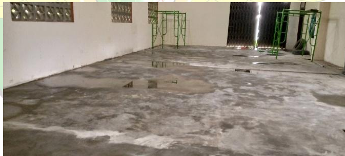
Gambar 4.16 Kondisi lantai gedung powerhouse sebelum epoksi (Sumber : Dokumentasi Penulis)
