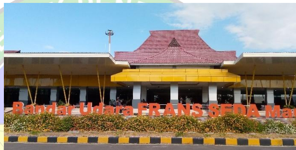
Gambar 4.2 Terminal Bandar Udara Frans Seda (Sumber : Dokumentasi Penulis)
