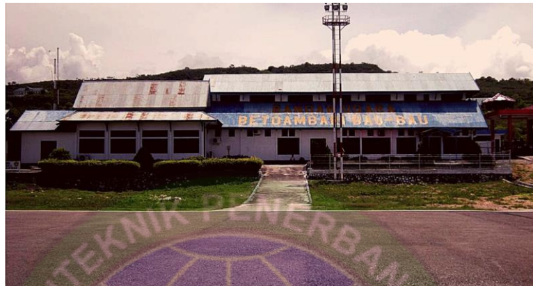
Gambar 2. 1 Bandar Udara Betoambari Baubau (Sumber : Dokumentasi Bandar Udara Betoambari Baubau)
