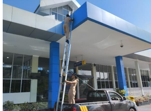
Perbaikan atap terminal keberangkatan
