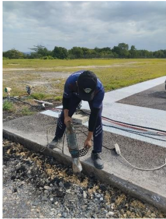
Breaker aspal di area runway 04
