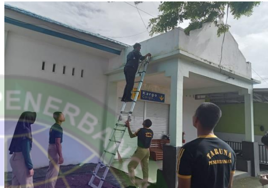
Gambar 4. 24 Pemasangan tangga (Sumber: Penulis)
