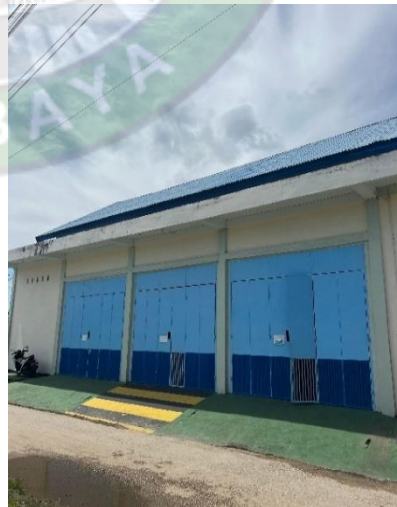
Gambar 4. 7 Gedung Workshop (Sumber: Penulis)
