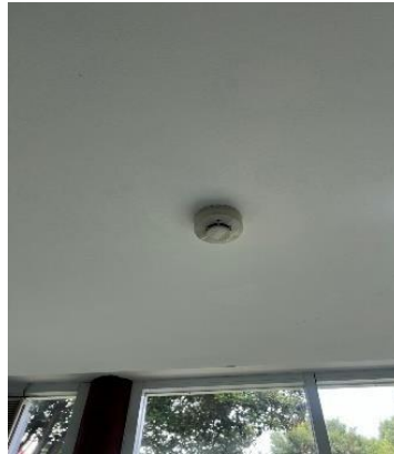
Gambar 3.12 Smoke Detector Sumber : Dokumentasi 14 Februari 2025
