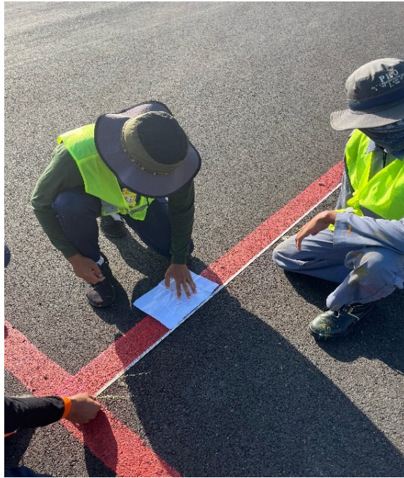
Gambar 4.23 Pengukuran Marka No Parking Area (Sumber : Dokumen Penulis)
