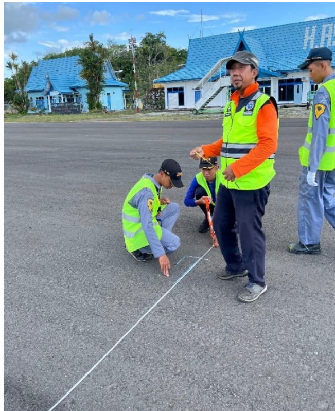
Gambar 4.22 Pengukuran Marka Nose Wheel Position (Sumber : Dokumen Penulis)
