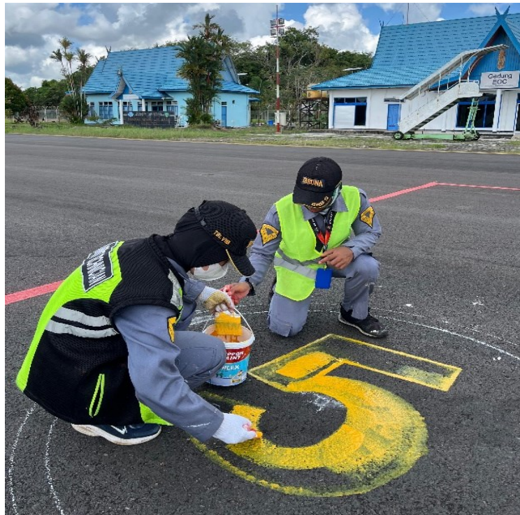
Gambar 4.29 Pengecatan Aircraft Stand Number (Sumber : Dokumen Penulis)
