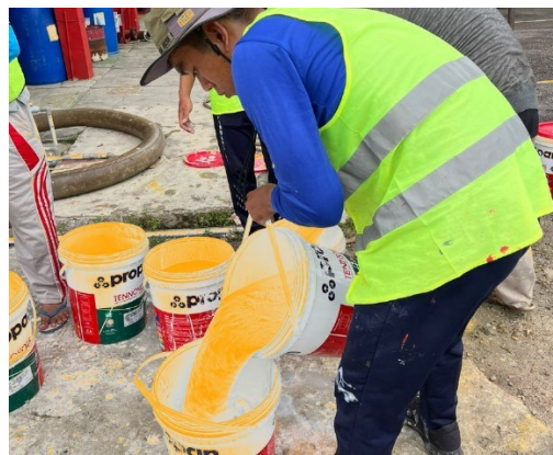
Gambar 4.21 Pencampuran Cat Dengan Air (Sumber : Dokumen Penulis)
