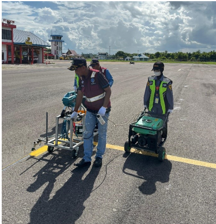
Gambar 4.27 Pengecatan Marshaller Stop Line (Sumber : Dokumen Penulis)
