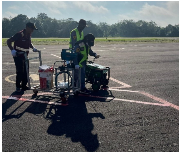
Gambar 4.26 Pengecatan No Parking Area (Sumber : Dokumen Penulis)
