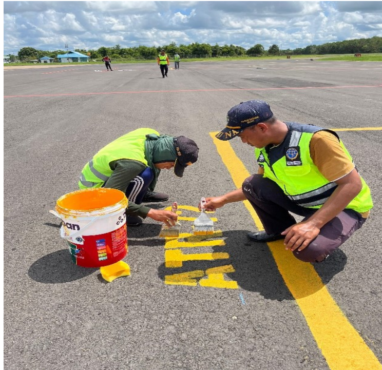
Gambar 4.28 Pengecatan Aircraft Type Designation (Sumber : Dokumen Penulis)
