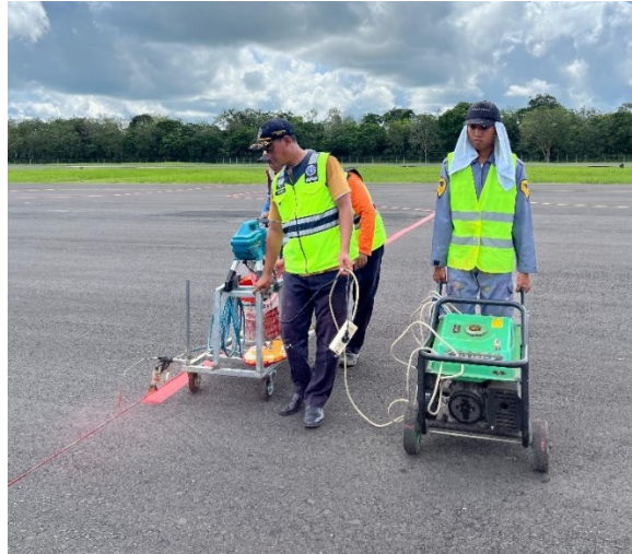
Gambar 4.25 Pengecatan Apron Safety Line (Sumber : Dokumen Penulis)
