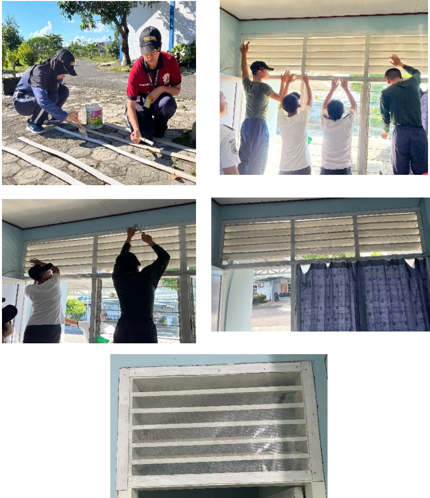
Gambar 4.31 Proses Pemasangan Jaring-Jaring (Sumber : Dokumen Penulis)
