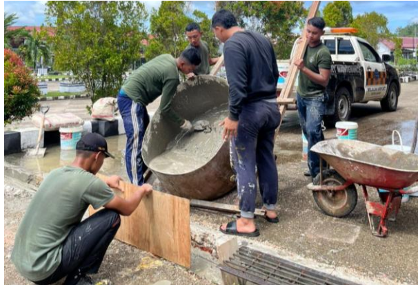
Gambar 4. 42 Penuangan Campuran Beton
