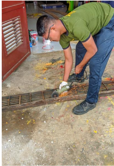
Gambar 4. 41 Pemotongan Besi Untuk Tulangan
