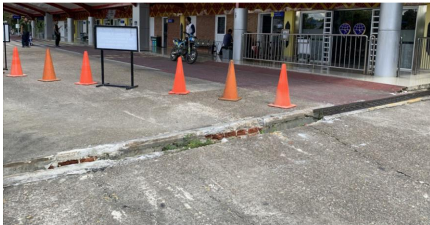
Gambar 4. 13 Drainase Teminal Penumpang
