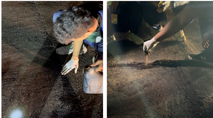
Gambar 4. 18 Proses pemberian aspal cair dan pasir pada tepi area patching (sumber: Dokumen penulis 2024)
