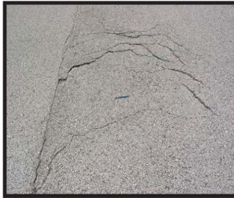
Gambar 3. 3 Retak Slippage (sumber: KP 94 Tahun 2015)
