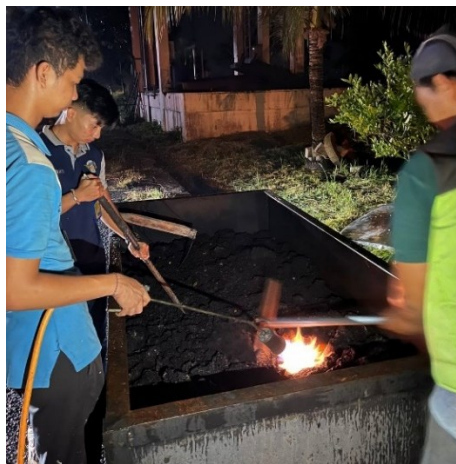
Gambar 4. 15 proses Pembakaran asphalt hotmix (sumber: Dokumen penulis 2024)
