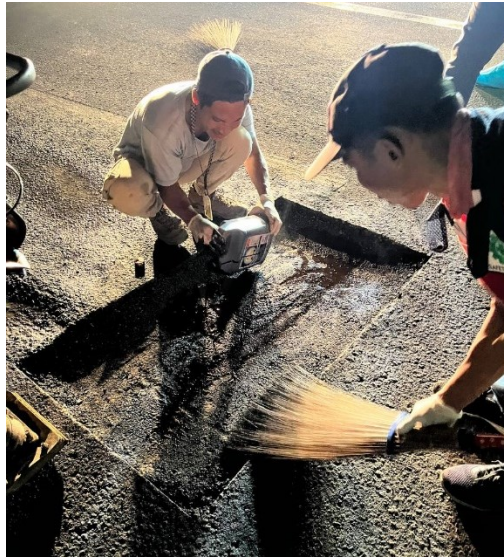
Gambar 4. 14 Proses Penghamparan Take coat (sumber: Dokumen penulis 2024)
