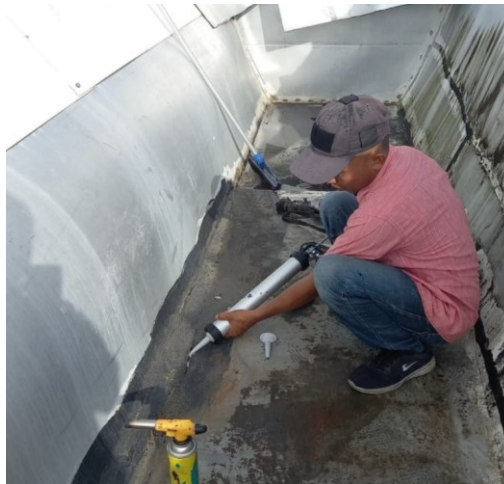
Gambar 4. 21 Perbaikan Talang dengan sealant pada area fix bridge 15 (sumber: Dokumen penulis 2024)
