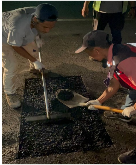
Gambar 4. 16 Proses Penghamparan Asphalt (sumber: Dokumen penulis 2024)
