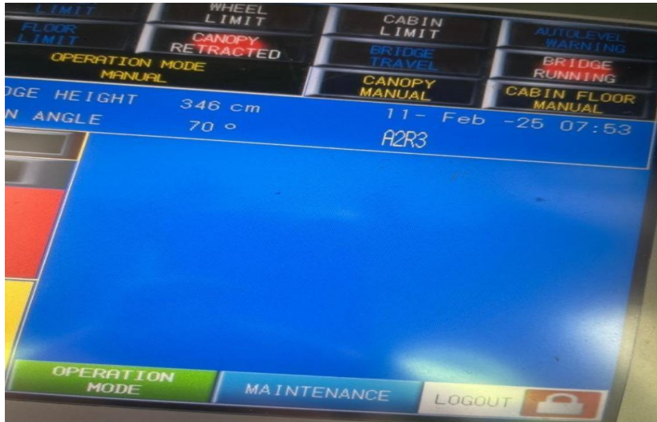
Gambar 4. 2 layar monitor Aviobridge tidak menyala
