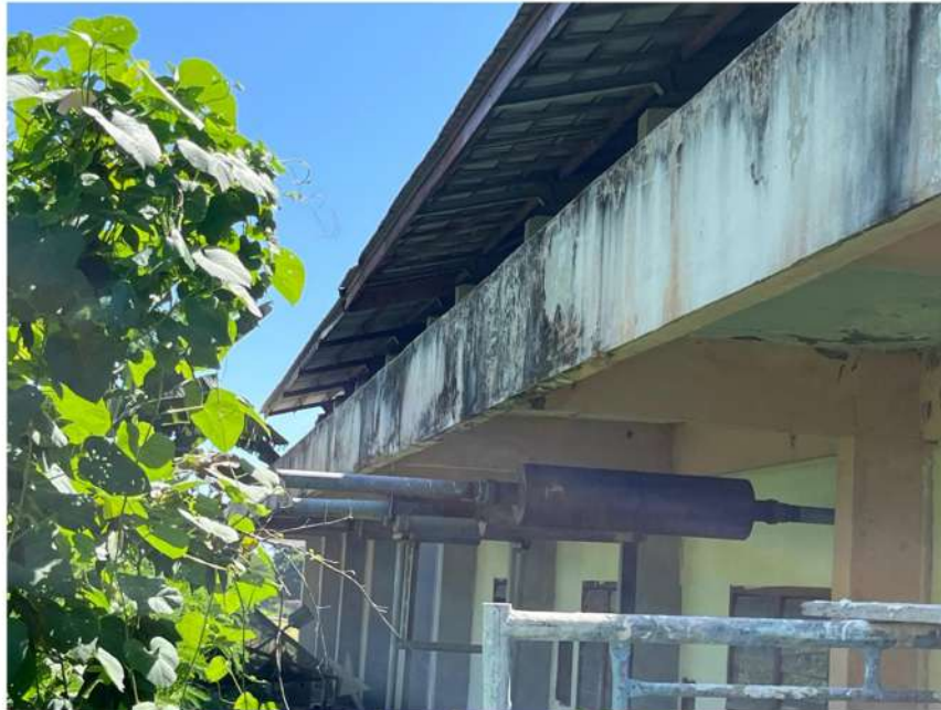
Gambar 4. 16 Kondisi Gedung Power House sebelum pengecatan (Sumber : dokumentasi penulis)
