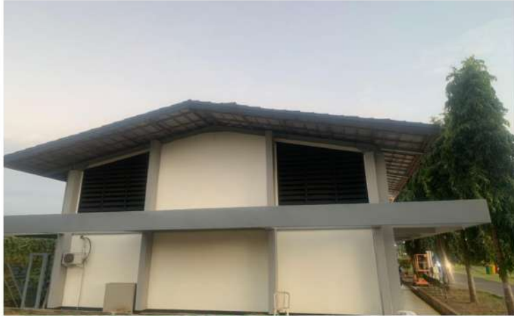
Gambar 4. 28 Dokumentasi pasca pengecatan (sumber : dokumentasi penulis)
