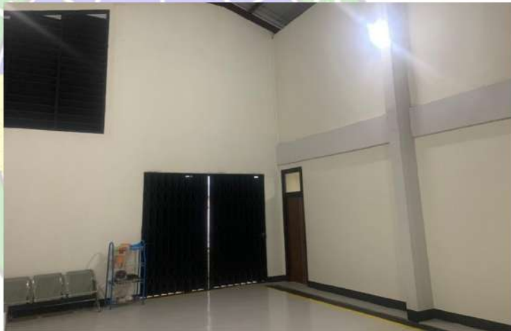
Gambar 4. 29 Dokumentasi pasca pengecatan (Sumber : dokumentasi penulis)
