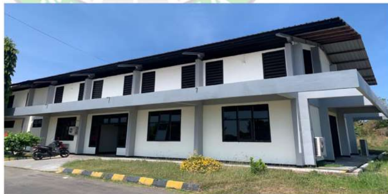
Gambar 4. 8 Gedung Power House (Sumber : dokumentasi penulis)
