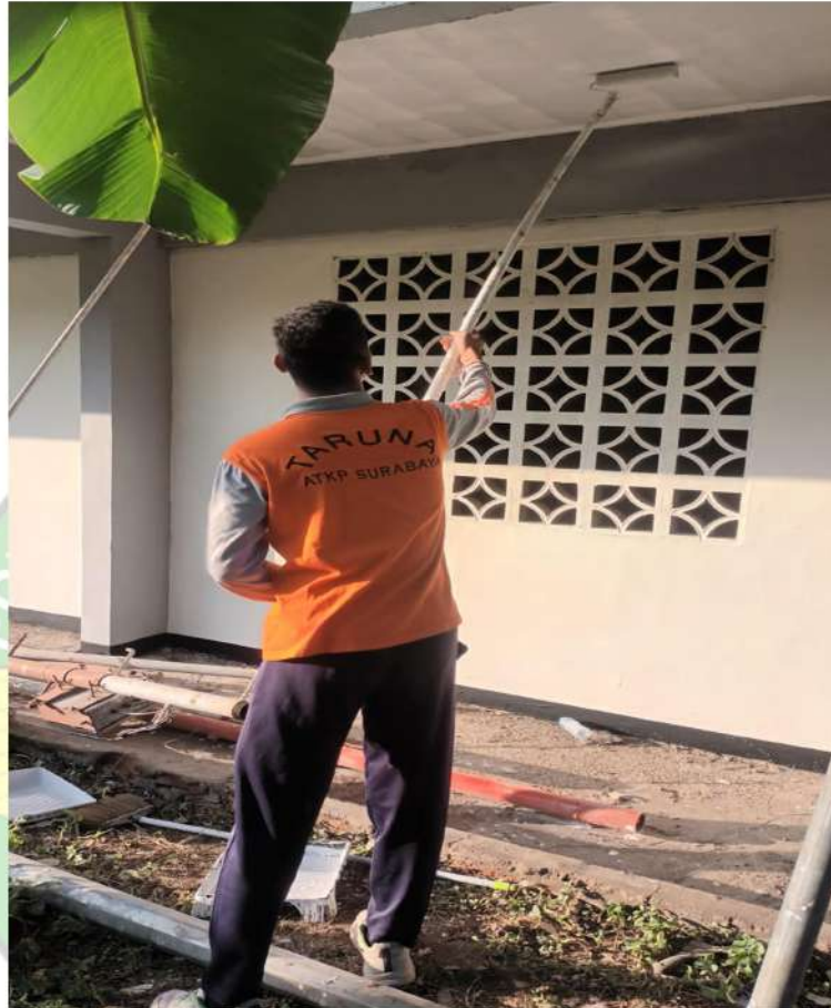
Gambar 4. 27 Proses pengecatan tembok (Sumber : dokumentasi penulis)
