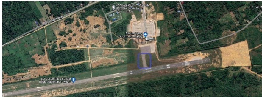
Gambar 4. 2 Taxiway Bandar Udara Sugimanuru
