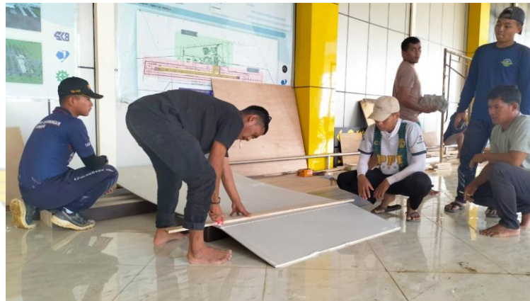
Gambar 4. 15 Pengukuran dan Pemotongan
