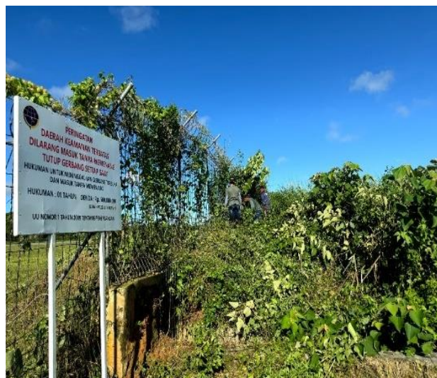
Gambar 4. 19 Perawatan Pagar BRC Sisi Udara
