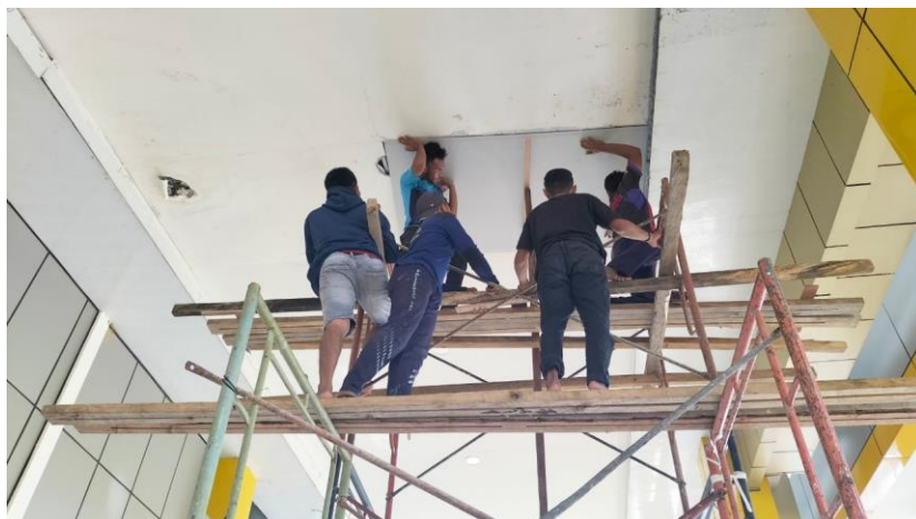
Gambar 4. 16 Pemasangan kasiboard
