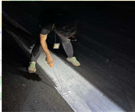
Gambar 4. 13 proses pengecatan marka centerline runway (Sumber : Dokumentasi Penulis,2024)
