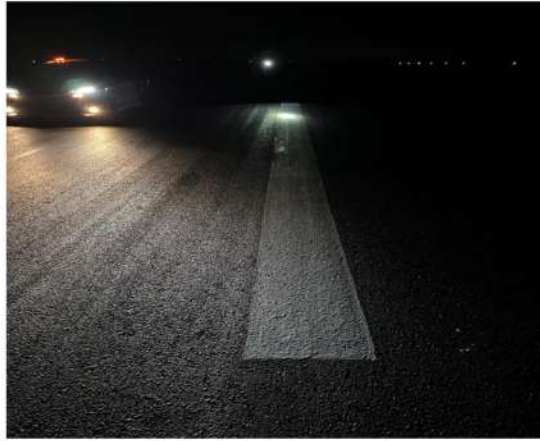
Gambar 4. 14 hasil pengecatan ulang marka centerline runway (Sumber : Dokumentasi Penulis,2024)
