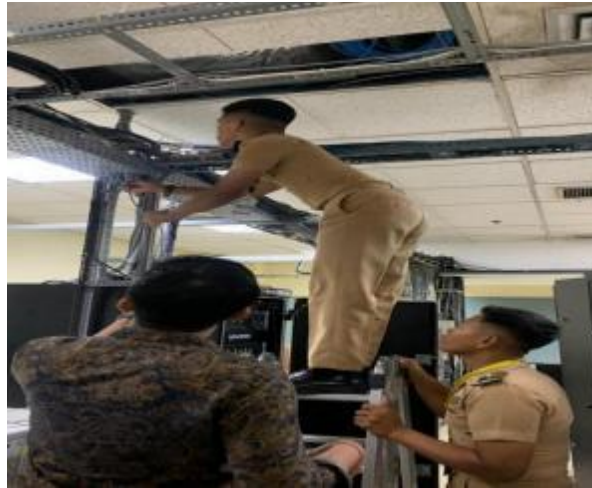
Melakukan penarikan kabel, dari rack server Recoder, ke walk Station(4/10/2024)
