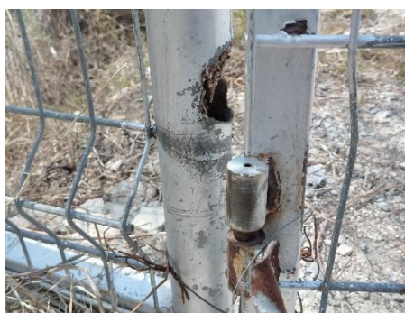
Gambar 4. 11 Kondisi kerusakan pagar gedung cargo (Sumber: Dokumen Pribadi, 2024)
