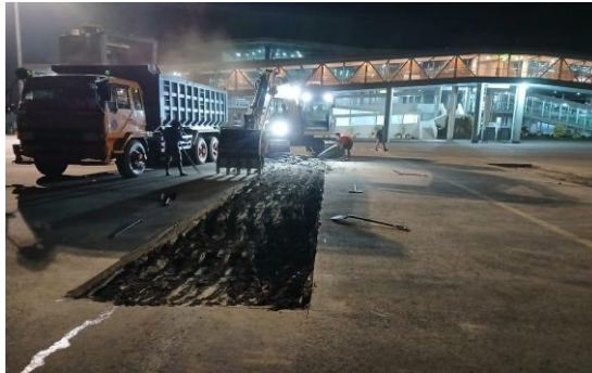
Gambar 4. 15 Penggalian dengan excavator (Sumber: Dokumen Pribadi, 2024)
