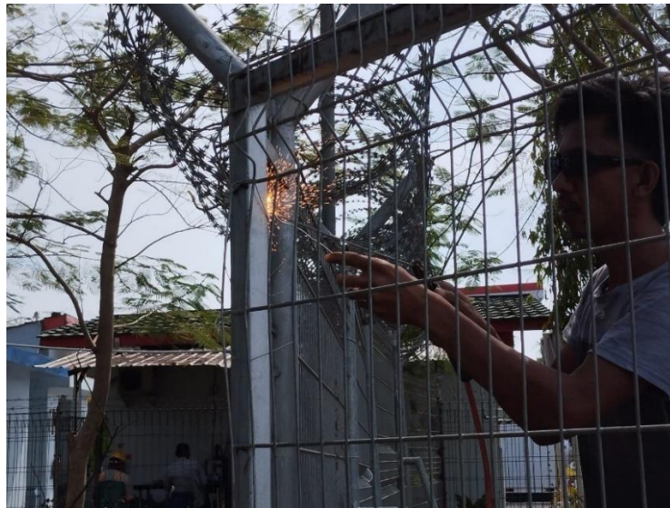
Gambar 4. 23 Pengelasan Pagar
