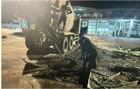
Gambar 4. 18 Penuangan Adonan Beton (Sumber: Dokumen Pribadi, 2024)
