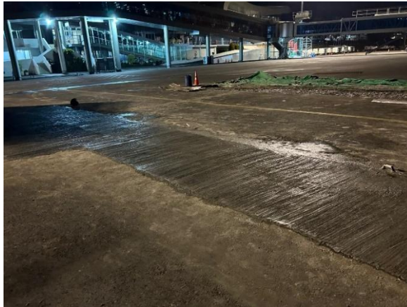
Gambar 4. 20 Pembuatan Pola Garis
