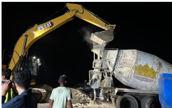
Gambar 4. 17 Pencampuran Adonan Beton (Sumber: Dokumen Pribadi, 2024)
