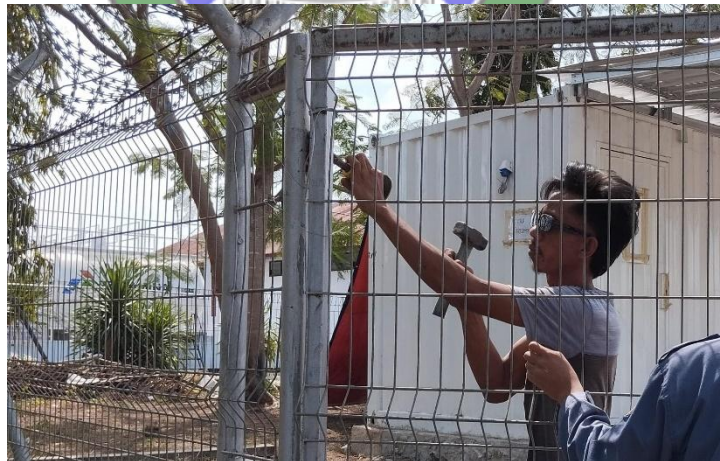
Gambar 4. 22 Pelepasan Engsel Pagar
