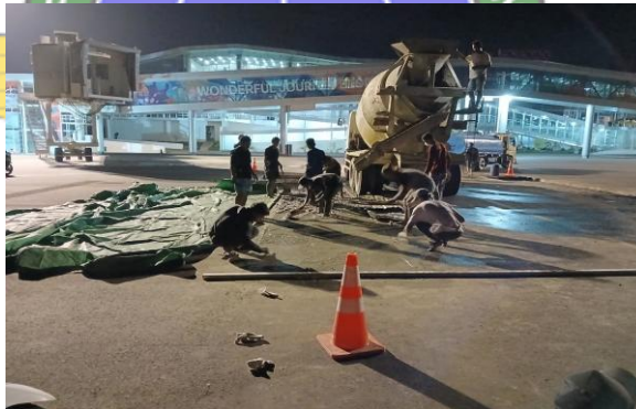
Gambar 4. 19 Perataan Adonan Beton (Sumber: Dokumen Pribadi, 2024)
