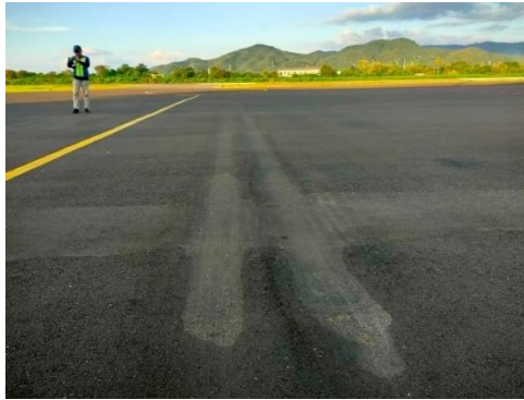
Gambar 4. 10 Kondisi Penurunan Permukaan pada Jalur Roda (Sumber: Dokumen Pribadi, 2024)
