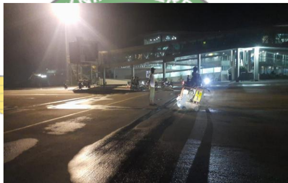
Gambar 4. 14 Pembongkaran dengan asphalt cutter
