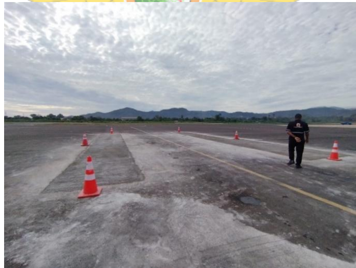
Gambar 4. 21 Hasil Pekerjaan Patching Apron
