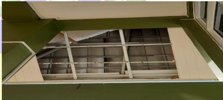
Gambar 4. 10 Kondisi plafon yang rusak di terminal kedatangan (Sumber: Dokumentasi Penulis)
