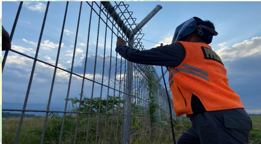
Gambar 4. 6 Pengelasan antara tiang galvanis dengan tiang pagar eksisting (Sumber: Dokumentasi Penulis)
