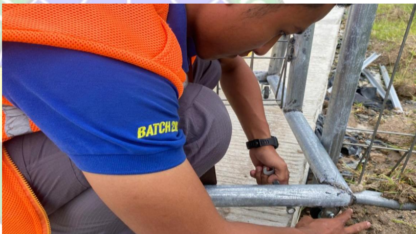
Gambar 4. 4 Pemasangan Roda Dibagian Bawah Tiang Galvanis (Sumber: Dokumentasi Penulis)
