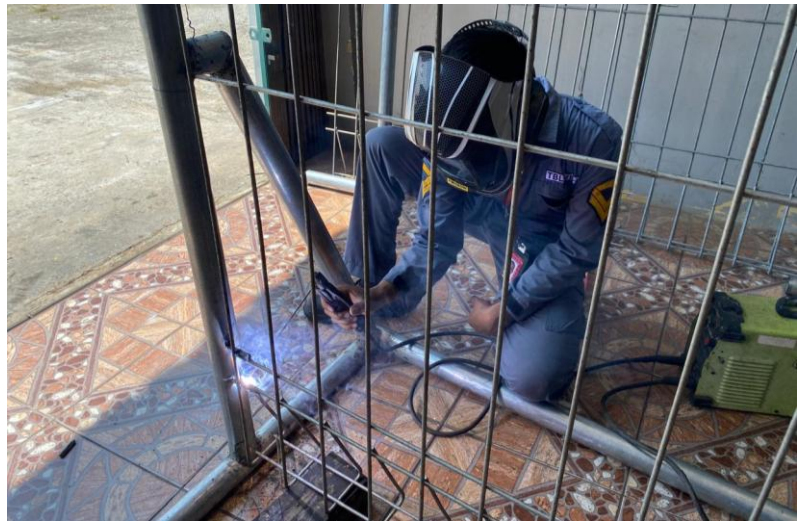
Gambar 4. 3 Pengelasan BRC ke Tiang Galvanis (Sumber: Dokumentasi Penulis)
