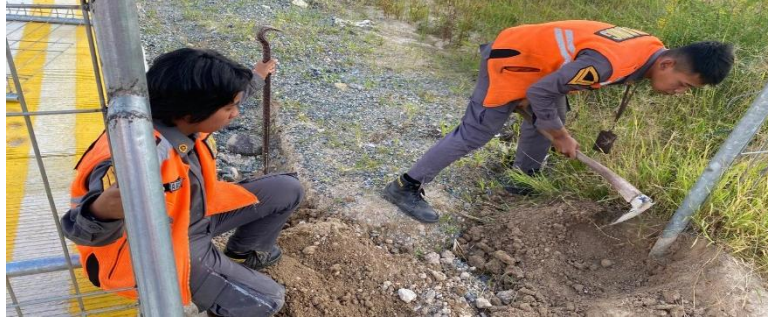
Gambar 4. 5 Pekerjaan Penggalian Pondasi (Sumber: Dokumentasi Penulis)
