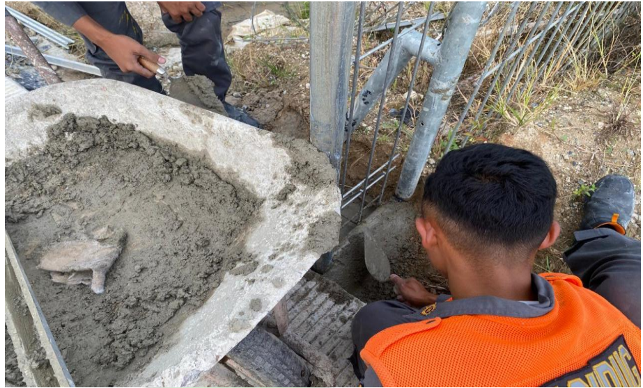
Gambar 4. 7 Pekerjaan Pengecoran Pondasi (Sumber: Dokumentasi Penulis)
