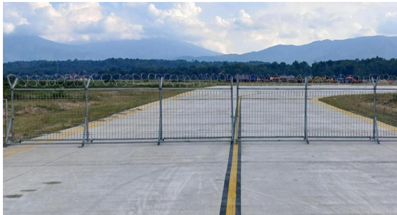
Gambar 4.9 Hasil Pengerjaan Pagar Taxiway Baru (Sumber: Dokumentasi Penulis)
