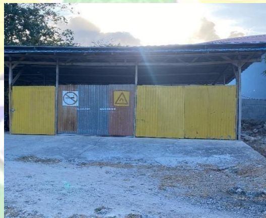
Gambar 4.14 Gudung Operasional Sumber : Olahan penulis, 2024
