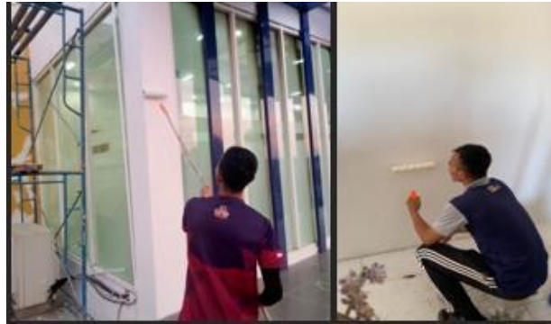
Gambar 4. 33 Pengecatan Sumber : Olahan Penulis, 2024
