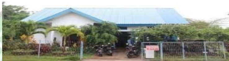
Gambar 4. 11 Gedung PH Sumber : Olahan penulis, 2024
