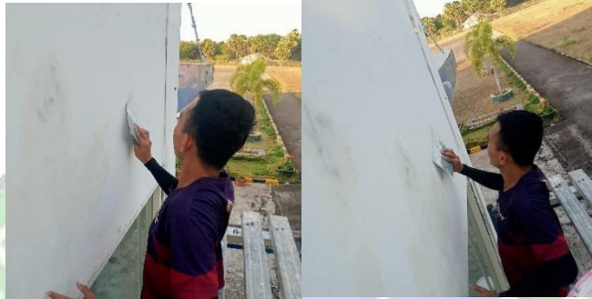
Gambar 4. 31 Pelapisan Pelamir Sumber : Olahan penulis, 2024
