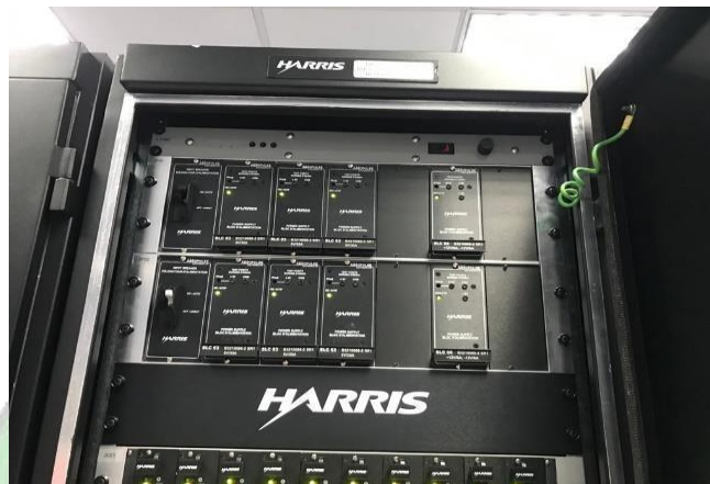
Gambar 3 . 8 Power Supply HARRIS Sumber : Dokumentasi Penulis (2024)
