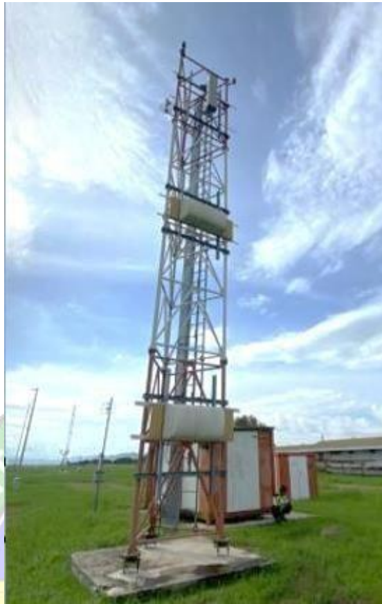
Gambar 3 . 42 Antenna GP Thales Sumber : Dokumentasi Penulis (2024)
