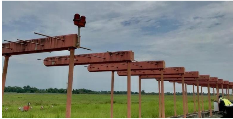
Gambar 3 . 31 Antenna Localizer 03 Sumber : Dokumentasi Penulis (2024)
