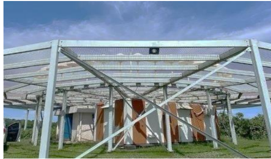
Gambar 3 . 20 Antenna DVOR MKS Sumber : Dokumentasi Penulis (2024)
