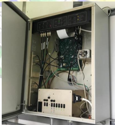
Gambar 3 . 46 Middle Marker Selex Sumber : Dokumentasi Penulis (2024)
