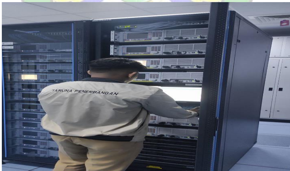
Gambar 3 .73 radio HF FIC di MER Sumber : sumber penulis (2024)
