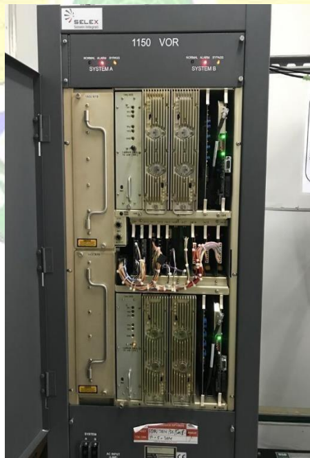
Gambar 3 . 23 Rak Cabinet DVOR MAK Sumber : Dokumentasi Penulis (2024)
