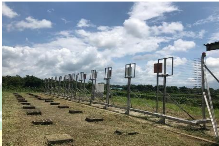
Gambar 3 . 31 Antenna Localizer 13 Sumber : Dokumentasi Penulis (2024)
