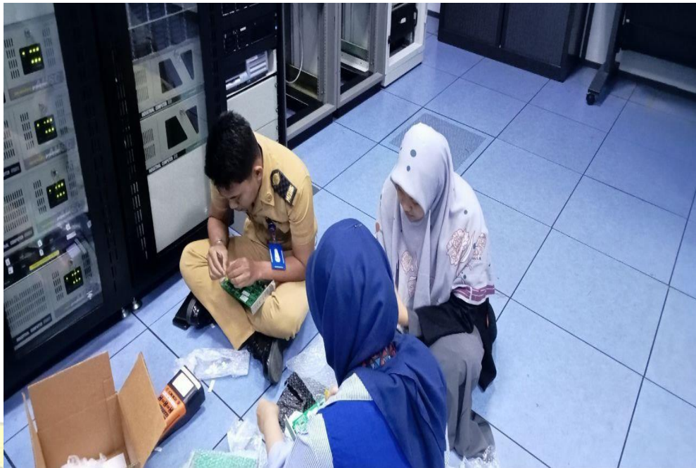
Gambar Lampiran 3. Melakukan pergantian signal selector
