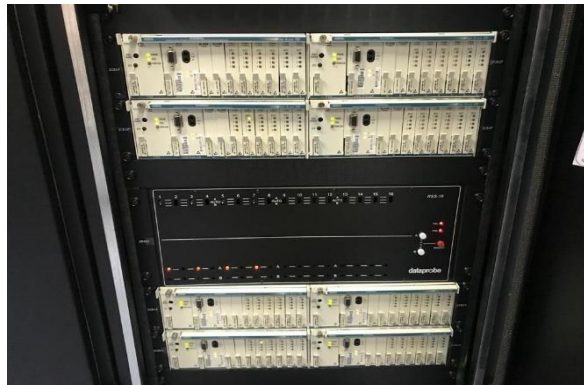
Gambar 3 . 5 Adtran Channel Bank Sumber ; Dokumentasi Penulis (2024)
