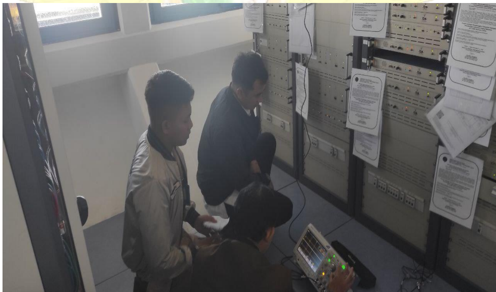
Gambar Lampiran 2. Melakukan ground chek bulanan pada radio ADC TX di tower
