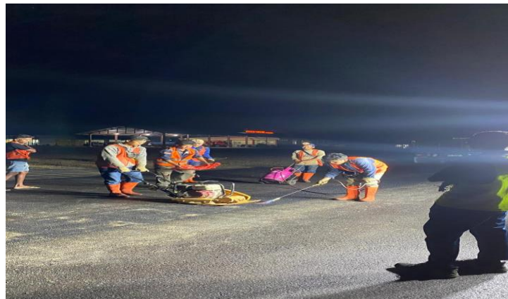
Gambar 4. 23 Pemadatan aspal Sumber : Olahan penulis, 2024
