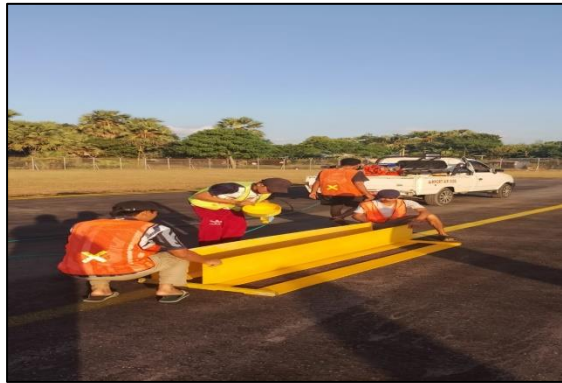
Gambar 4. 24 Pengecatan marka Sumber : Olahan penulis, 2024
