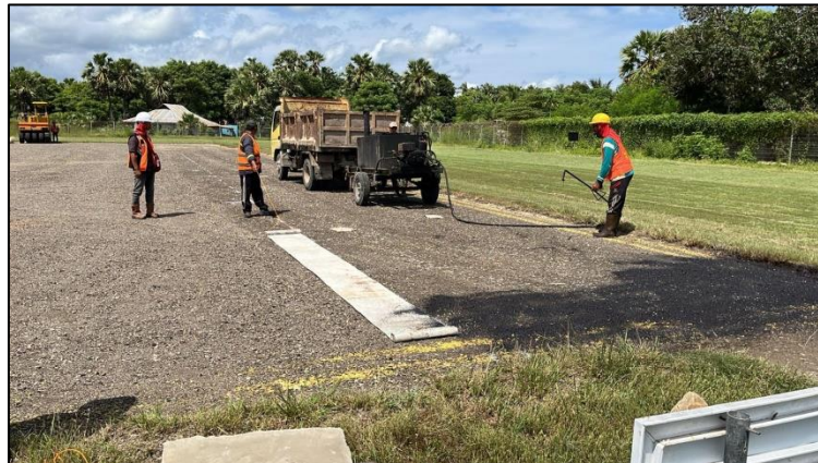
Gambar 4. 21 Pekerjaan Tack coat Sumber : Olahan penulis, 2024
