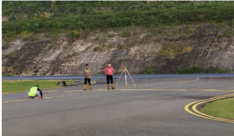
Gambar 4. 32 Kegiatan Pengukuran Elevasi Permukaan (Sumber : Dokumentasi Pribadi, 2024)
