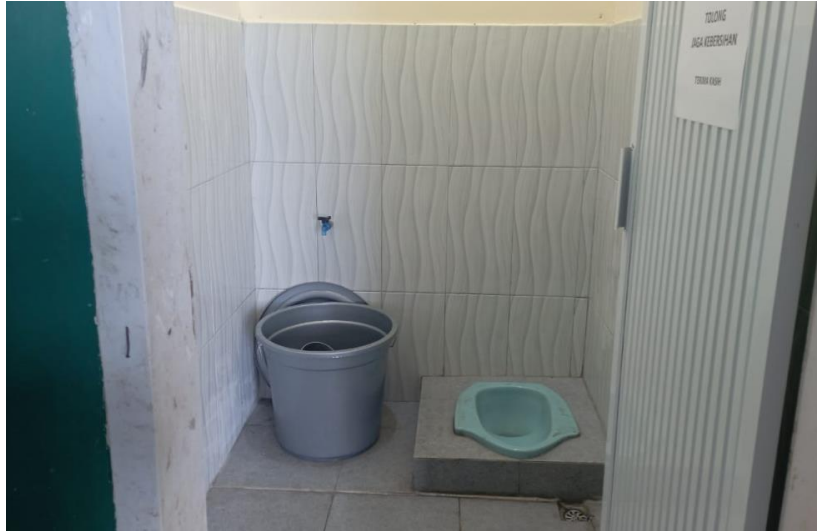
Gambar 4. 39 Finishing (Sumber : Dokumentasi Pribadi, 2024)
