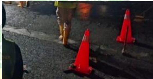
Gambar 4. 19 Cone Pembatas Jalan (Sumber : Dokumentasi Pribadi, 2024)
