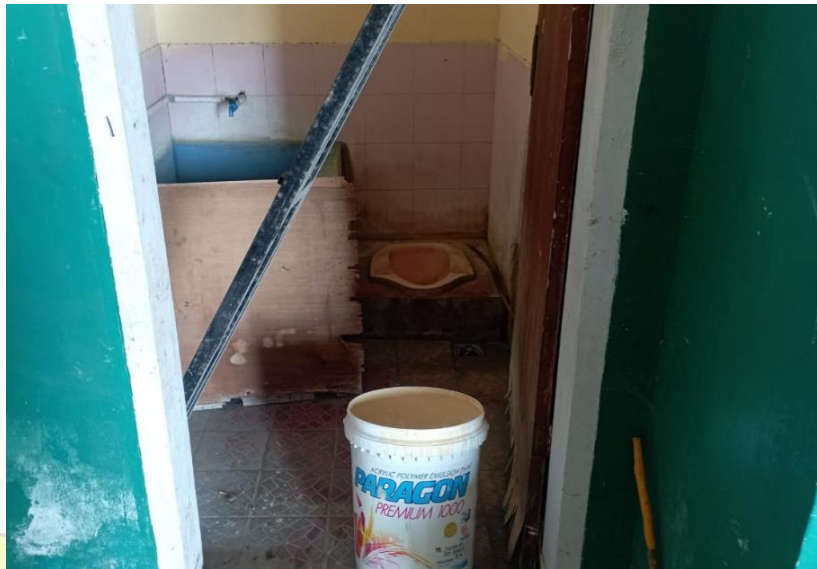
Gambar 4. 37 Pembongkaran (Sumber : Dokumentasi Pribadi, 2024)
