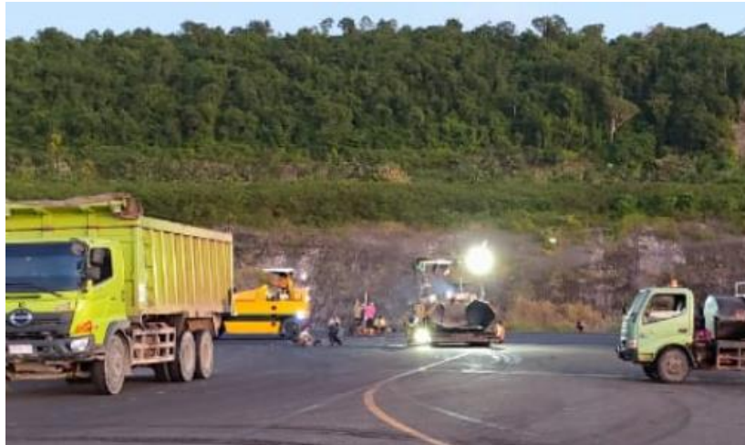
Gambar 4. 34 Penghamparan Aspal (Sumber : Dokumentasi Pribadi, 2024)
