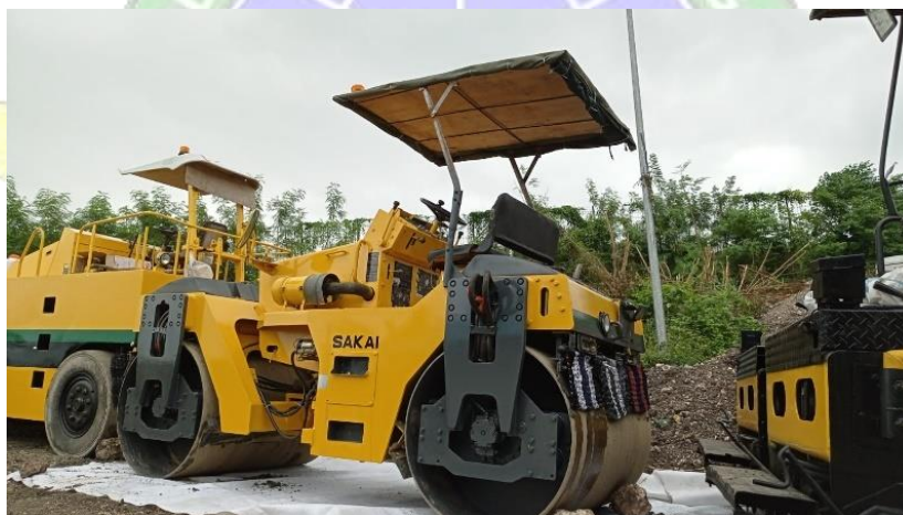
Gambar 4. 29 Tandem Roller (Sumber : Dokumentasi Pribadi, 2024)
