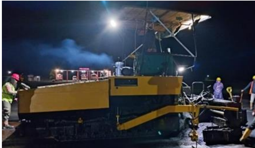
Gambar 4. 28 Asphalt Finisher (Sumber : Dokumentasi Pribadi, 2024)
