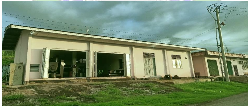
Gambar 4. 9 Gedung Listrik (Sumber : Dokumentasi Pribadi, 2024)
