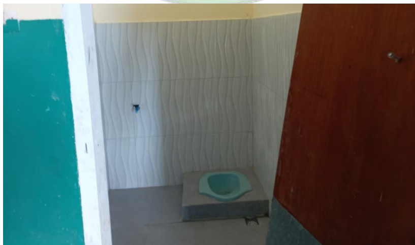
Gambar 4. 38 Perbaikan (Sumber : Dokumentasi Pribadi, 2024)
