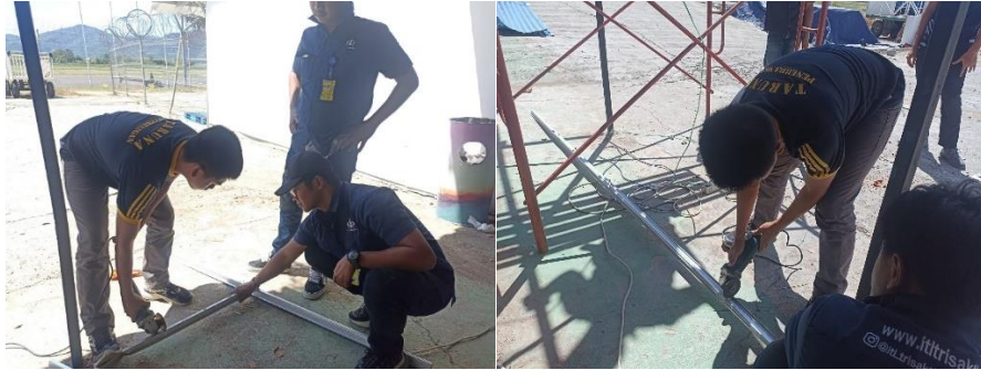
Gambar 4. 22 Proses Pemotongan Reng dan Kanal c
