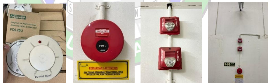
Gambar 3. 15 Fixed Temperature Heat Detector pada stand kuliner terminal 1A (Sumber : dokumentasi penulis 14 Februari 2025)
