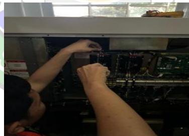
Gambar 3. 29 Penggantian Modul yang Bermasalah (Sumber : dokumentasi penulis 11 Februari 2025)
