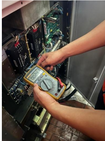
Gambar 3. 30 Cek Tegangan Suplai daya (Sumber : dokumentasi penulis 11 Februari 2025)
