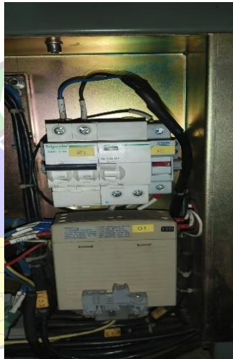
Gambar 3. 20 Module MCB ( Miniature Circuit Breaker ) Pada Scp 2A Line 4 Terminal 1A (Sumber : dokumentasi penulis 11 Februari 2025)
