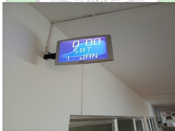
Gambar 3. 14 Slave Clock pada Body Lounge terminal 1B Keberangkatan (Sumber : dokumentasi penulis 1 Januari 2025)
