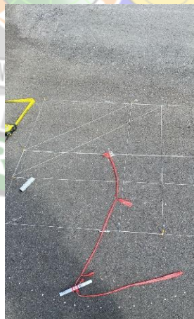
Gambar 4. 21 Pembuatan mal marka angka Apron
