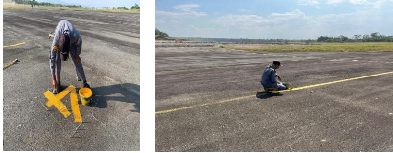
Gambar 4. 25 Proses pengecatan pada desain marka Apron baru
