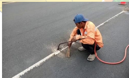
Gambar 3. 6 Alat Bakar untuk penghapusan Cat Marka Jalan
