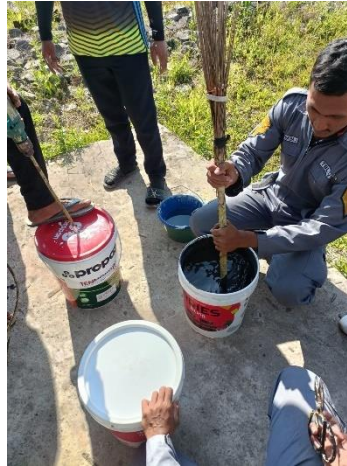
Gambar 4. 29 Proses pencampuran cat dengan air
