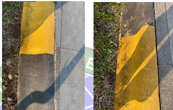
Gambar 4. 31 Kondisi kanstin sebelum dilakukan pengecatan ulang
