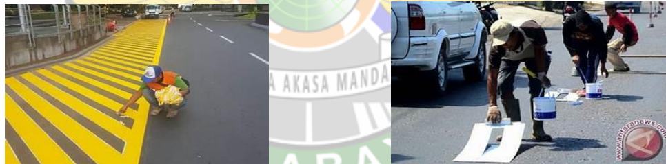
Gambar 3. 4 Penghapusan marka jalan dengan metode tradisional
