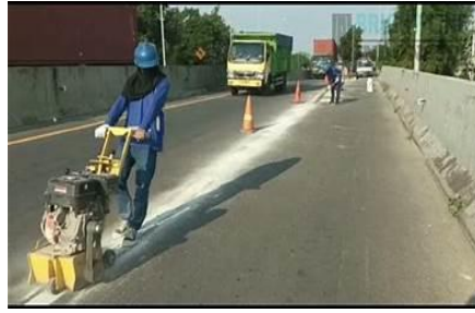
Gambar 3. 5 Alat Scraper untuk Penghapus Cat Marka Jalan
