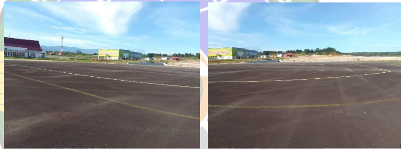
Gambar 4. 26 Marka Apron sebelum dilakukan penghapusan serta pengecatan ulang
