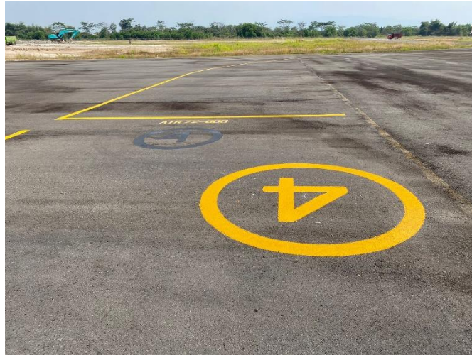
Gambar 4. 27 Marka Apron setelah dilakukan penghapusan serta pengecatan ulang
