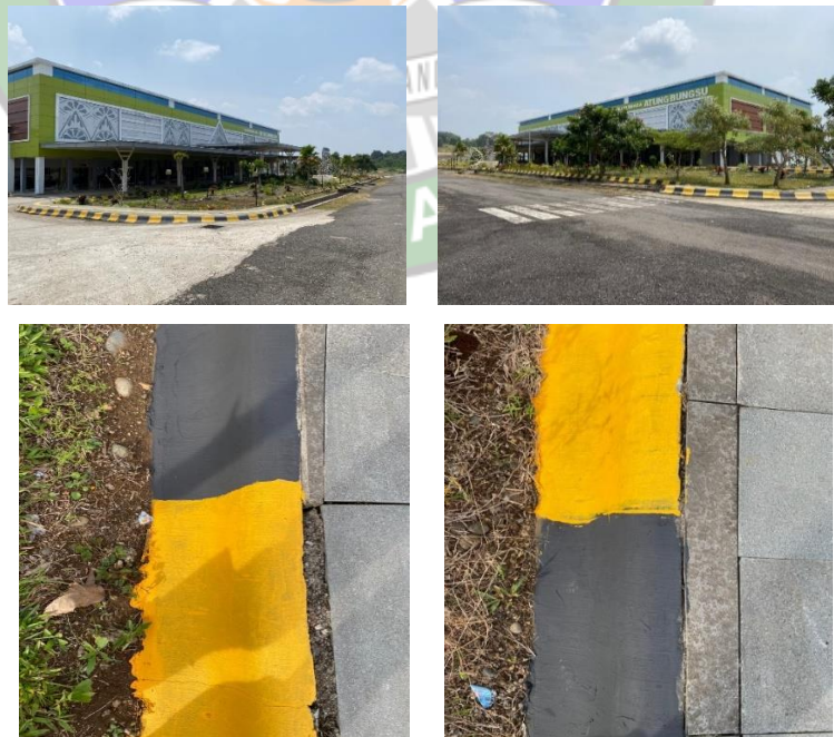
Gambar 4. 32 Kondisi kanstin setelah dilakukan pengecatan ulang
