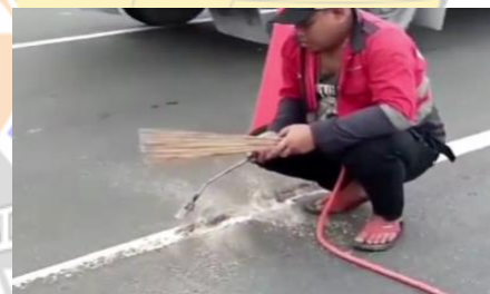
Gambar 3. 6 Alat Bakar untuk penghapusan Cat Marka Jalan
