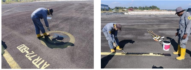
Gambar 4. 24 Proses penghapusan marka Apron yang salah
