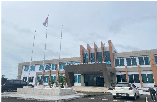
Gambar 4.8 Gedung Administrasi bandara Syamsudin Noor
