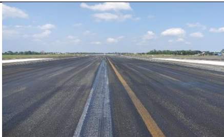
Gambar 4.27 Marka Center line Sebelum Pengecatan
