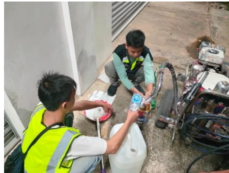
Gambar 4.22 Pencucian alat spray dengan thinner
