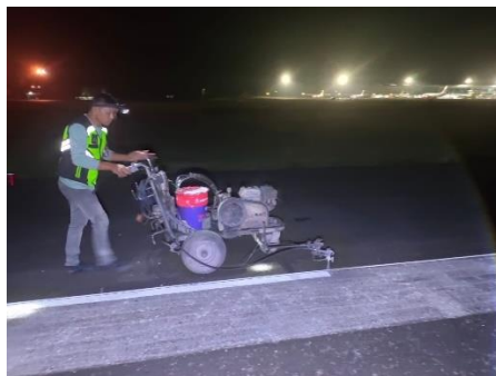
Gambar 4.20 Proses pengecatan dengan alat spray
