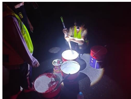
Gambar 4.16 Proses pencampuran cat dengan thinner
