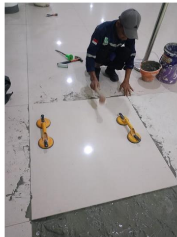
Gambar 4.33 Proses penuangan spesi dan pemasangan keramik
