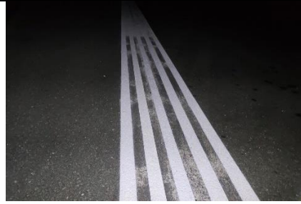
Gambar 4.24 Marka Side Strip Setelah Pengecatan
