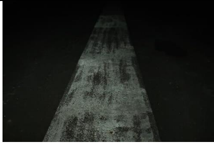
Gambar 4.23 Marka Side Strip Sebelum Pengecatan
