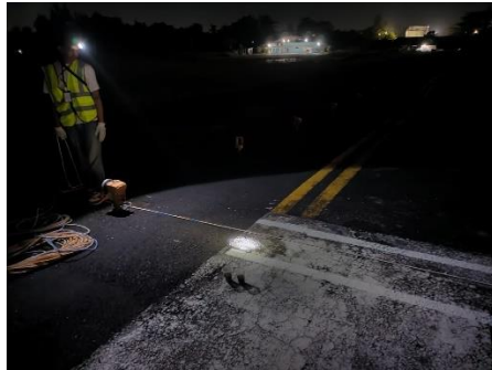
Gambar 4.19 Proses pemasangan tali pembatas cat
