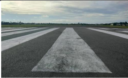
Gambar 4.25 Marka Threshold Sebelum Pengecatan
