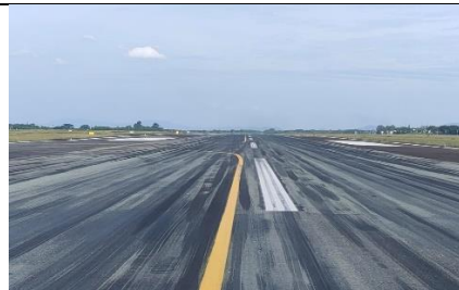
Gambar 4.28 Marka Center line Setelah Pengecatan
