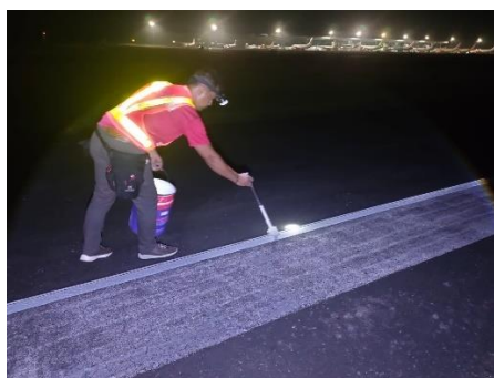
Gambar 4.21 Pengecatan ulang tepi yang kurang
