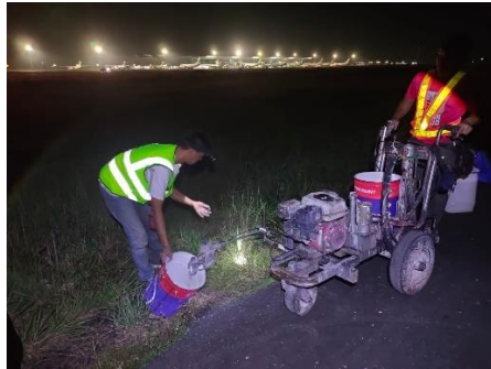
Gambar 4.17 Pengetestan alat spray cat
