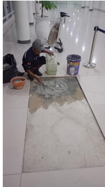
Gambar 4.32 Pembuatan Spesi
