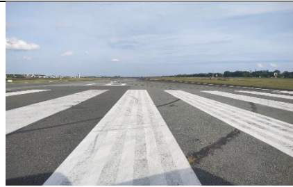
Gambar 4.26 Marka Threshold Setelah Pengecatan
