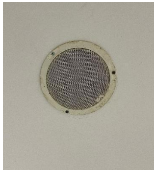
Gambar 3. 14 Celling Speaker PAS Sumber : Dokumentasi Penulis 2025
