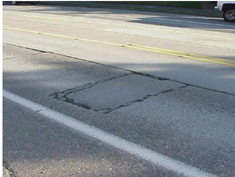
Gambar 3. 3 kerusakan pada tepi patching yang tidak sempurna (Sumber: slideshare.net/aguskerusakan-perkerasan-kaku )
