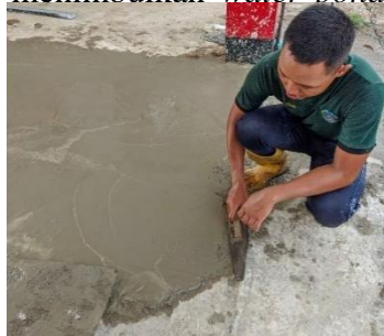
Gambar 4. 14 Meratakan menggunakan alat Plester
