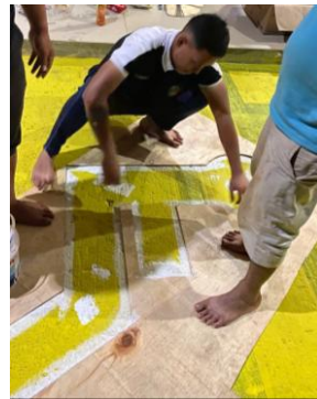
Gambar 4. 17 Membuat sketsa marka parkir disabilitas (Sumber: Dokumentasi Penulis, 2024)
