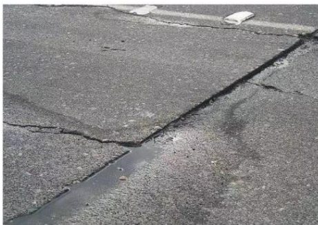
Gambar 3. 2 kerusakan pada joint (Sumber: slideshare.net/aguskerusakan-perkerasan-kaku )
