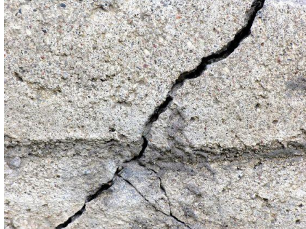
Gambar 3. 1 Kerusakan retak memanjang (Sumber: slideshare.net/aguskerusakan-perkerasan-kaku )
