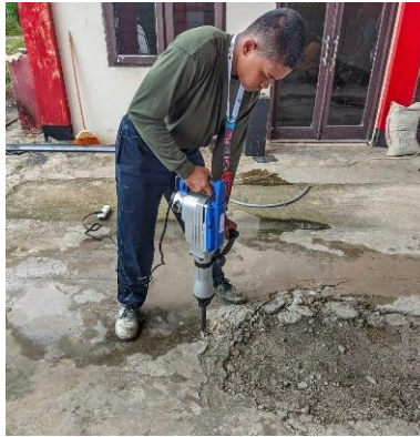
Gambar 4. 11 Pembongkaran Beton Menggunakan Jack Hammer (Sumber: Dokumentasi Penulis, Tahun 2024)
