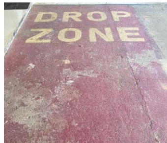
Gambar 4. 10 Kondisi marka drop zone (Sumber: Dokumentasi Penulis, Tahun 2024)
