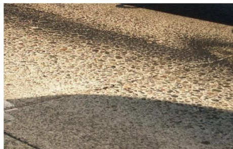
Gambar 3. 5 hilangnya kekesatan pada perkerasan (Sumber: slideshare.net/aguskerusakan-perkerasan-kaku )
