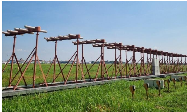
Gambar 3.3. 4 Antenna Localizer Sumber: Dokumentasi Penulis 2024
