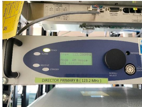
Gambar 3.11. 6 Menyalakan perangkat Rx VHF Sumber: Dokumentasi Penulis 2024
