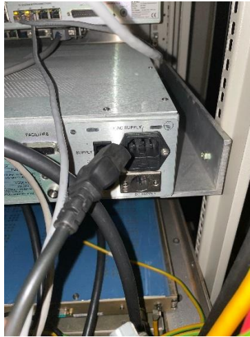
Gambar 3.11. 4 Melepas kabel lan ac supply
