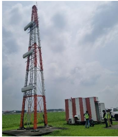
Gambar 3.3. 3 Shelter & Antenna Glide Path Sumber: Dokumentasi Penulis 2024
