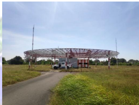
Gambar 3. 7 Antenna Peralatan DVOR Merk Interscam Sumber : Dokumentasi penulis 2024
