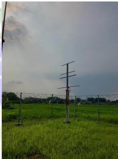
Gambar 3. 16 Middle Marker di Bandar Udara Internasional Juanda Surabaya Sumber : Dokumentasi penulis 2024
