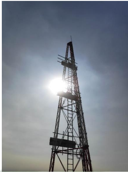
Gambar 3. 13 Antenna Glide Path Merk Normac Sumber : Dokumentasi Penulis 2024
