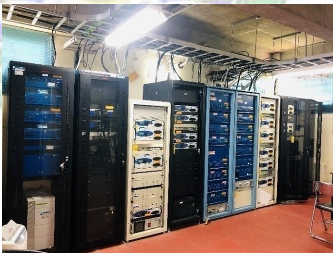
Gambar 3. 6 Radio Transmitter VHF A/G Sumber : Dokumentasi penulis 2024
