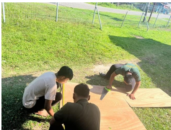
Gambar 4. 18 Pemotongan Triplek (Sumber : Dokumentasi Pribadi, 2025)
