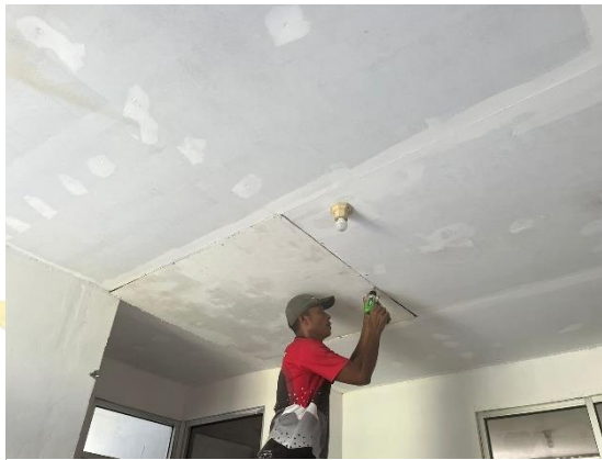
Gambar 4. 22 Pemasangan plafon baru
