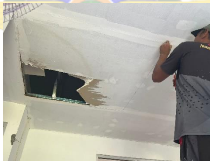
Gambar 4. 17 Plafon yang berlubang karena lapuk (Sumber: Dokumentasi Pribadi)
