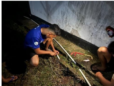
Gambar 4. 27 Pemasangan sambungan pipa (Sumber: Dokumentasi pribadi)
