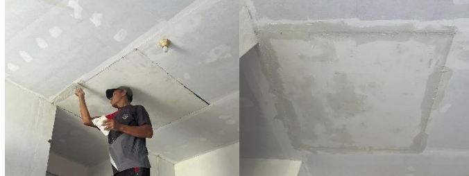
Gambar 4. 24 Peletakan Plamir
