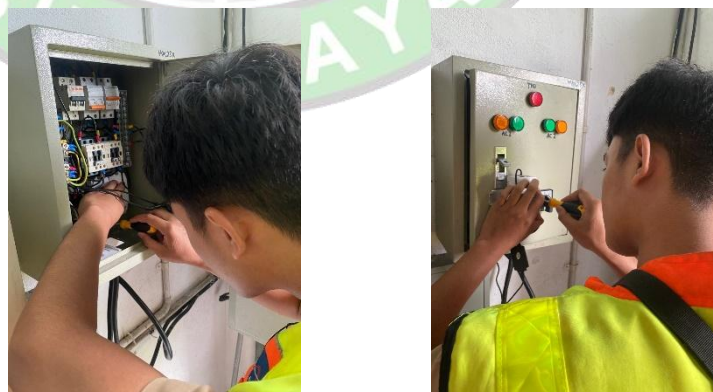
Gambar 3.44 Pemasangan Modul di Middle Marker 25 R
