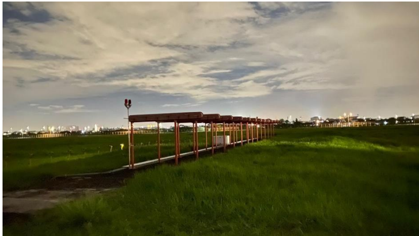
Gambar 3.15 Antena Localizer Sumber : Hasil Dokumentasi Penulis 2024
