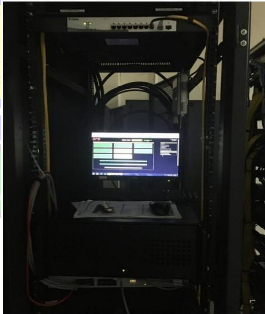
Gambar 3.22 Server M-LAT di Processing Room .
