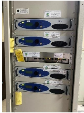
Gambar 3.7 Radio pemancar ATIS merk PAE Sumber : Perum LPPNPI Cabang JATSC, 2024
