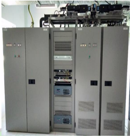
Gambar 3 .19 Pengelola Data Radar PSR di Kantor Pusat
