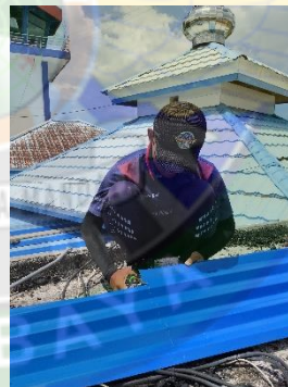
Gambar 4. 15 Pemotongan Seng
