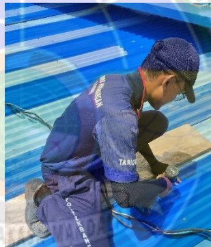
Gambar 4. 18 Pemasangan Seng
