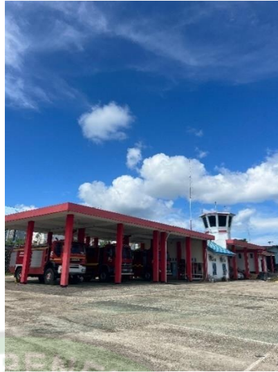
Gambar 4. 4 Gedung PKP-PK (Sumber: Penulis)
