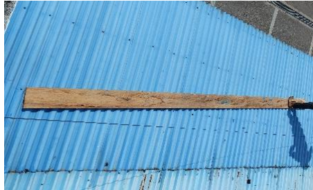
Gambar 4. 17 Pemasangan Papan Kayu
