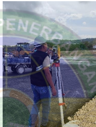
Gambar 4. 21 Penentuan Siku dan Titik Tengah
