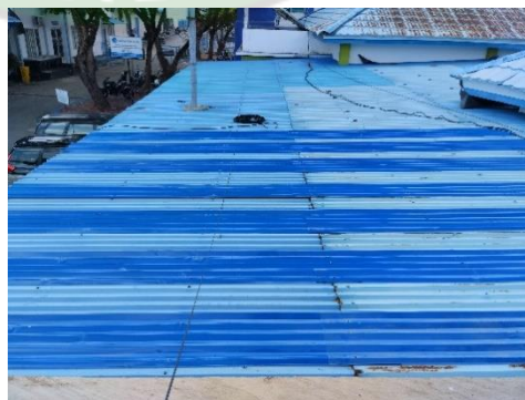
Gambar 4. 19 Kondisi setelah pemasangan
