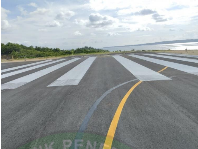
Gambar 4. 25 Kondisi setelah dilakukan pengecatan
