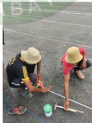
Gambar 4. 22 Pemasangan Paku dan Tali
