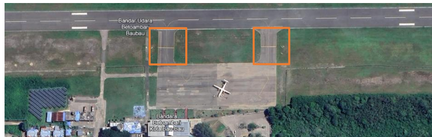
Gambar 4. 10 Taxiway (Google Earth, di akses tanggal 1 Januari 2025)
