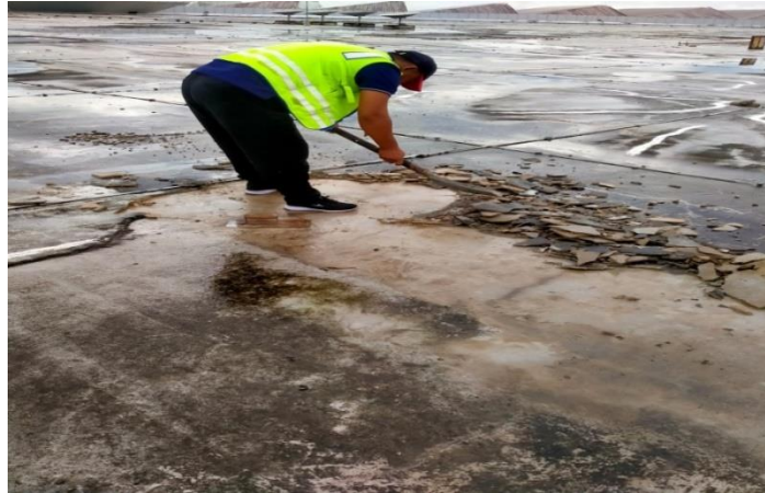
Gambar 4. 21 Pembersihan permukaan
