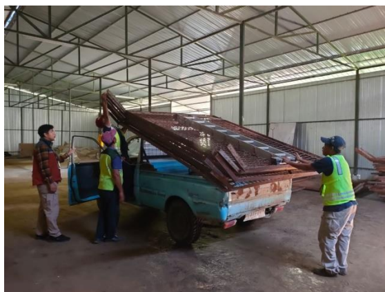
Gambar 4. 12 Proses pengangkutan pagar dari gudang ke lokasi pekerjaan
