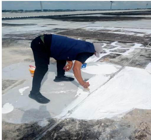
Gambar 4. 24 Aplikasi Waterproofing
