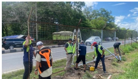
Gambar 4. 14 Pemasangan pagar parimeter
