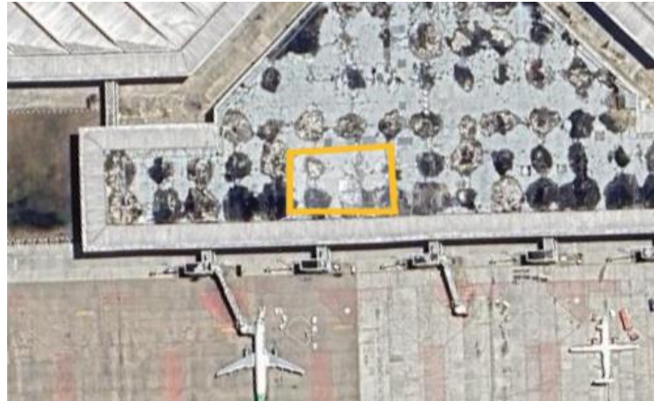
Gambar 4. 20 Lokasi pekerjaan Waterproofing
