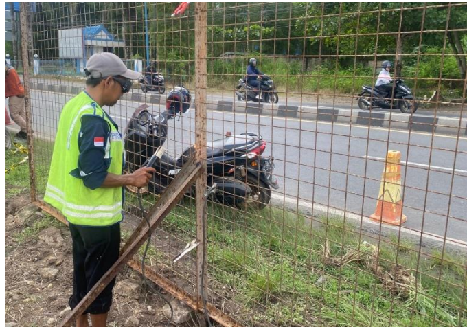
Gambar 4. 15 Pengelasan pagar
