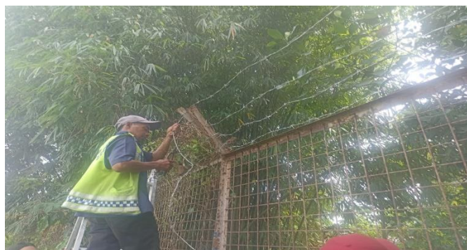
Gambar 4. 16 Pemasangan kawat razor
