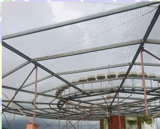
Gambar : 3. 28 Antena DVOR "MAK" Sumber : Dokumentasi Penulis (2024)
