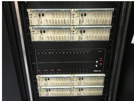
Gambar 3 . 42 Bank Channel Harris Sumber : Dokumentasi Penulis (2024)
