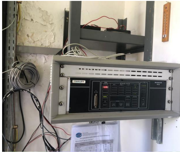
Gambar 3 . 26 Middle Marker Thales Sumber : Dokumentasi Penulis (2024)
