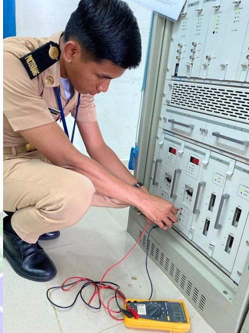
Gambar Lampiran 5. Pengukuran tegangan pada PSU DVOR MKS
