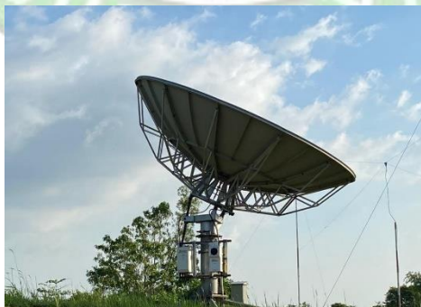
Gambar 3 . 58 Antenna VSAT Sumber : Dokumentasi Penulis (2024)
