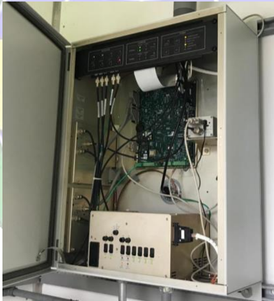
Gambar 3 . 25 Middle Marker Selex Sumber : Dokumentasi Penulis (2024)
