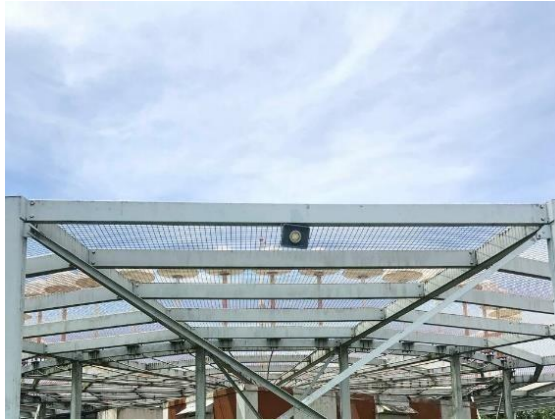
Gambar 3 . 1 Antenna DVOR MKS Sumber : Dokumentasi Penulis (2024)
