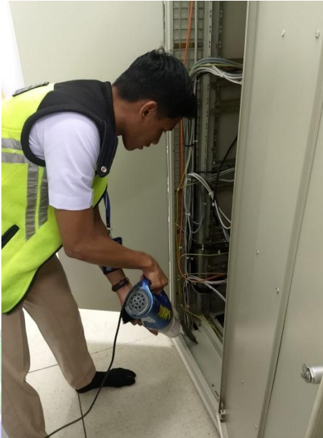
Gambar Lampiran 7 Melaksanakan Pembersihan pada Peralatan Radar
