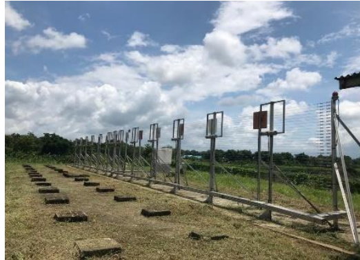
Gambar 3 . 12 Antenna Localizer 13 Sumber : Dokumentasi Penulis (2024)
