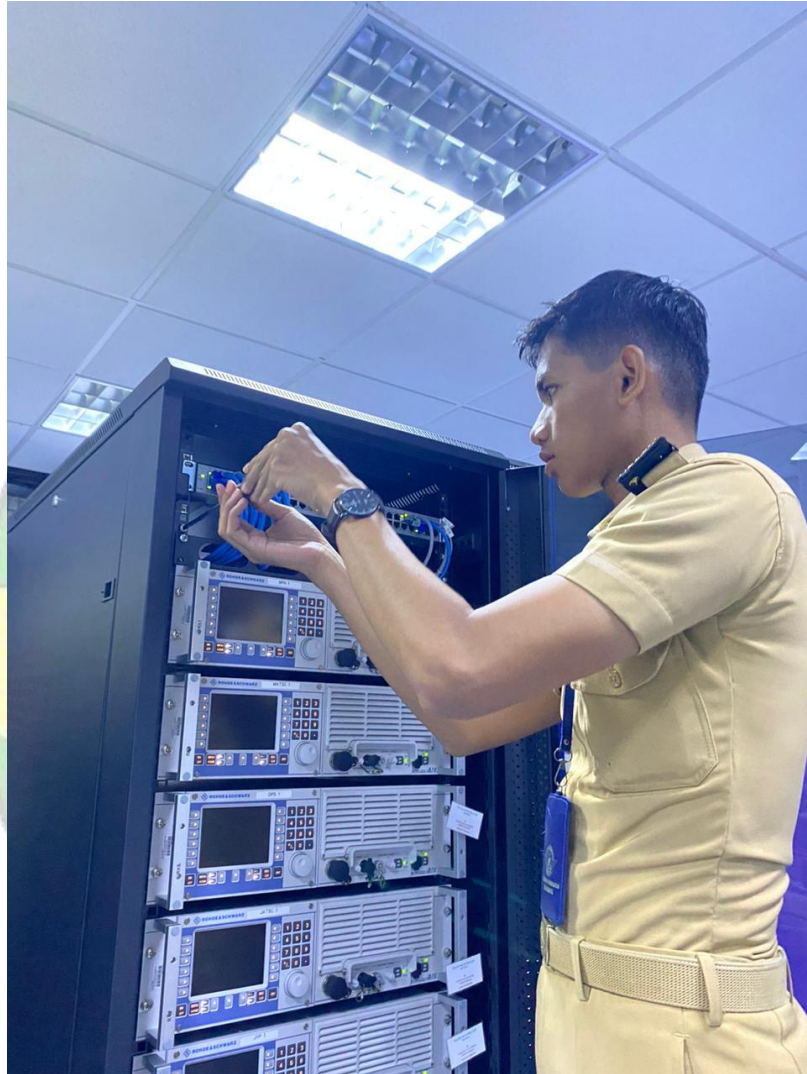
Gambar Lampiran 3. Melaksanakan pembersihan pada Fan peralatan FIC yang mengeluarkan suara yang berisik
