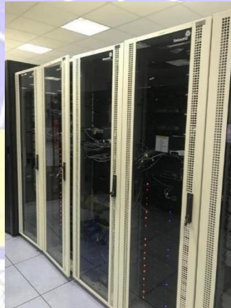
Gambar 3 . 59 Rak VSAT di MER Sumber : Dokumentasi Penulis (2024)
