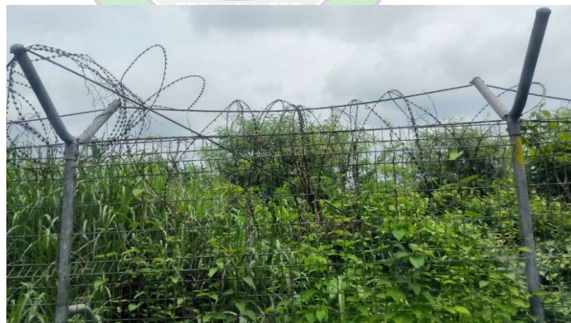
Gambar 4.6 Kawat Pagar Perimeter Yang Rusak
