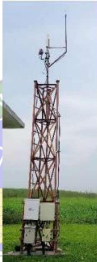
Gambar 3. 16 Antenna RU ( Remote Unit ) MLAT Merk SAAB Sumber: Dokumentasi Penulis
