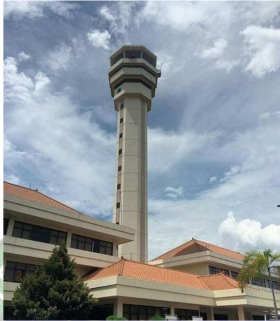
Gambar 2. 3 Kantor Perum LPPNPI Cabang Surabaya Sumber: Dokumentasi Penulis
