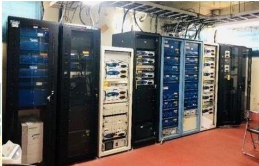
Gambar 3. 7 Radio Transmitter VHF A/G Sumber: Dokumentasi Penulis
