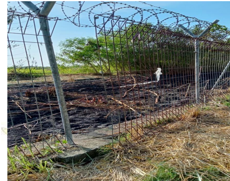
Gambar 4. 10 Kondisi pagar yang terlepas (sumber : Dokumentasi pribadi, 2024)
