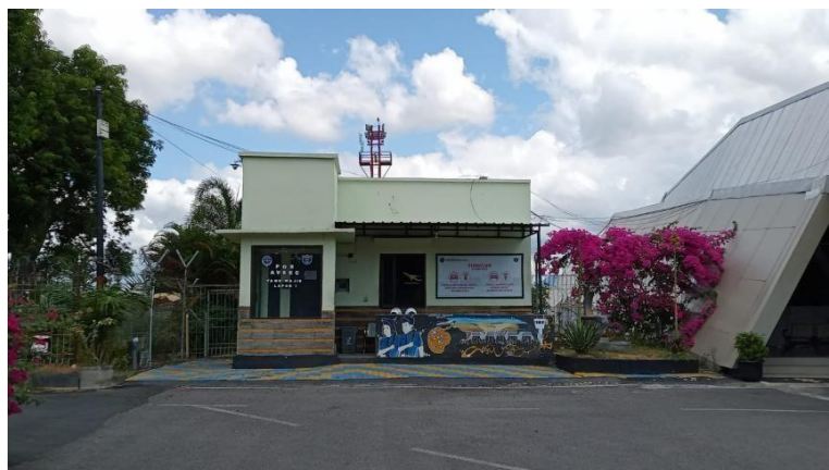
Gambar 4. 7 Gedung AVSEC ( Sumber : Dokumentasi Pribadi, 2024)
