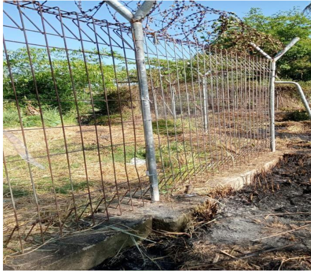
Gambar 4. 23 Pagar yang sudah di kawat dan di las (sumber : Dokumentasi pribadi, 2024)
