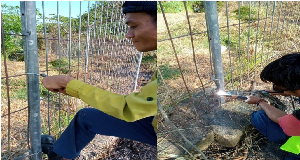
Gambar 4. 22 Perbaikan pagar perimeter
