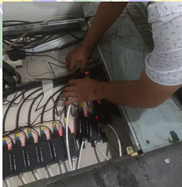
Gambar 3. 31 Pemasangan Kabel LAN ke Extender
