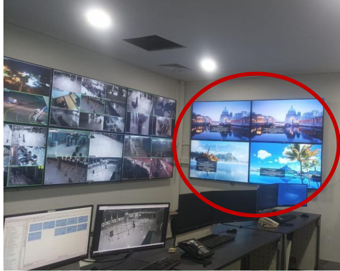
Gambar 3. 27 Display Monitor Tidak Menampilkan Input Video Sumber : Dokumentasi Penulis 2025
