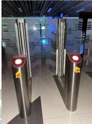
Gambar 3. 20 Passenger Barrier Gate Sumber : Dokumentasi Penulis 2025
