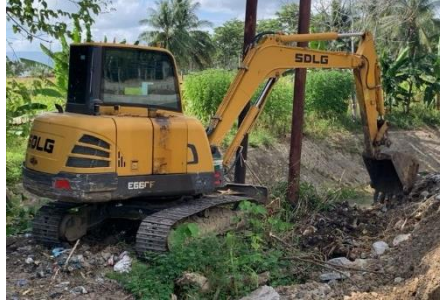
Gambar 4. 35 Excavator (Sumber: Dokumentasi Penulis, 2024)
