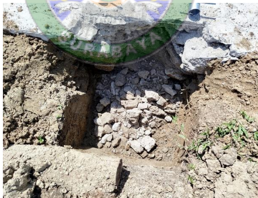
Gambar 4. 48 Pondasi tiang (Sumber: Dokumentasi Penulis, 2024)
