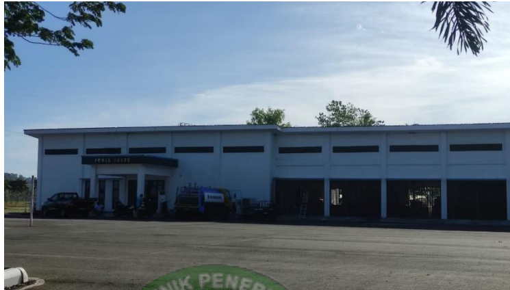
Gambar 4. 7 Gedung Power House (Sumber:Dokumentasi Pribadi)
