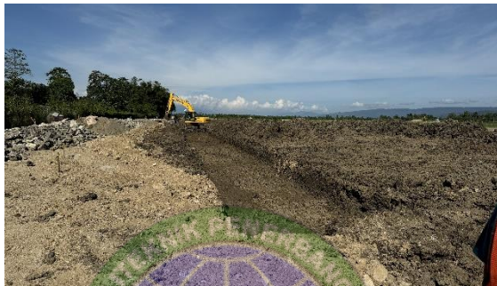
Gambar 4. 27 Penggalian Saluran (Sumber: Dokumentasi Pribadi, 2024)
