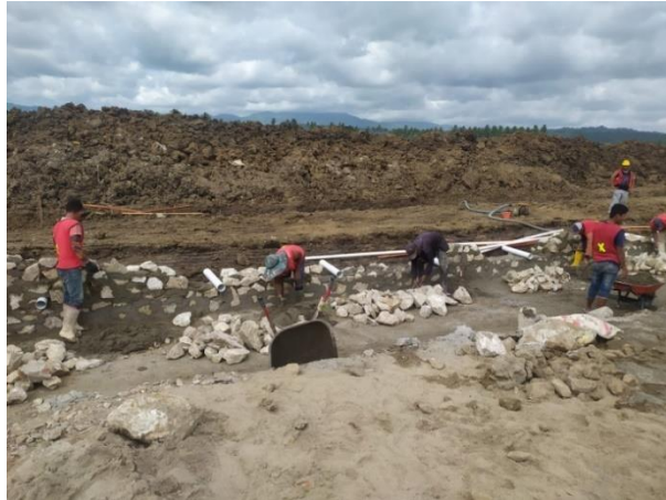
Gambar 4. 30 Pemasangan Batu dan Pipa (Gambar: Dokumentasi Penulis, 2024)
