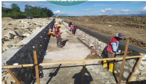
Gambar 4. 31 Plesteran Dinding Drainase (Gambar: Dokumentasi Penulis, 2024)
