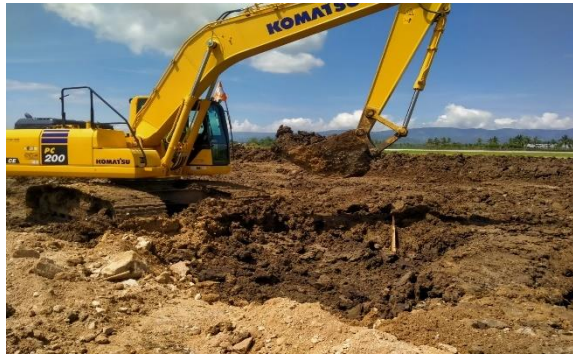
Gambar 4. 11 Excavator (Sumber:Dokumentasi Pribadi)
