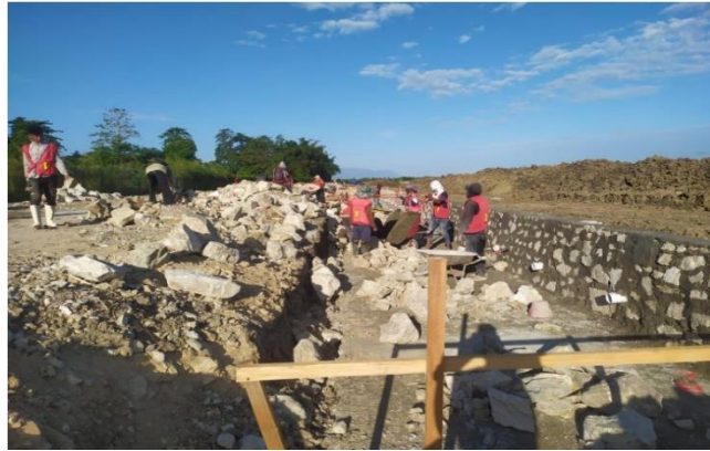
Gambar 4. 28 Timbunan Batu Kali (Sumber: Dokumentasi Penulis, 2024)
