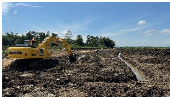
Gambar 4. 26 Pembersihan Lahan Menggunakan Excavator (Sumber:Dokumentasi Penulis,2024)
