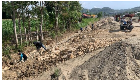
Gambar 4. 47 Pekerjaan tembok penahan tanah (Sumber: Dokumentasi Penulis, 2024)
