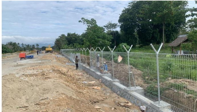
Gambar 4. 49 Pemasangan pagar (Sumber: Dokumentasi Penulis, 2024)
