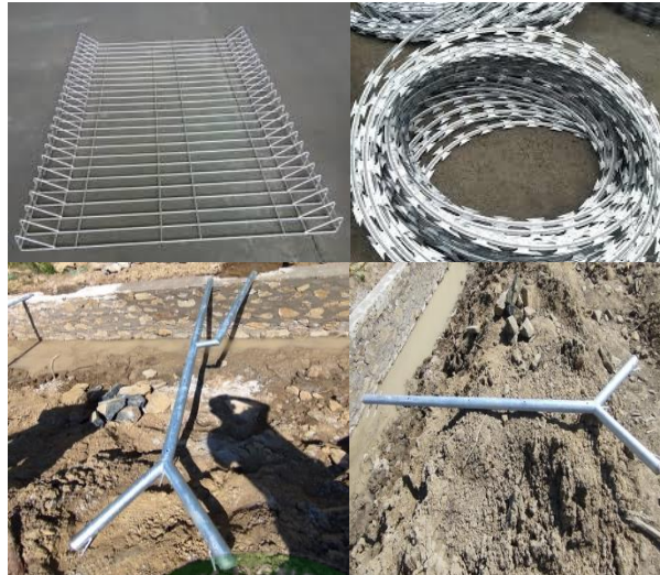
Gambar 4. 43 Satu Set Pagar BRC (Sumber: Dokumentasi Penulis, 2024)
