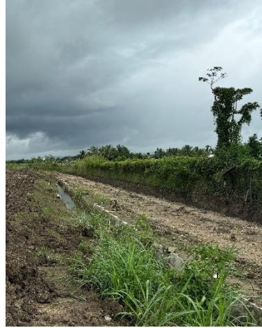
Gambar 4. 8 Drainase Eksisting (Sumber: Dokumentasi Penulis, 2024)
