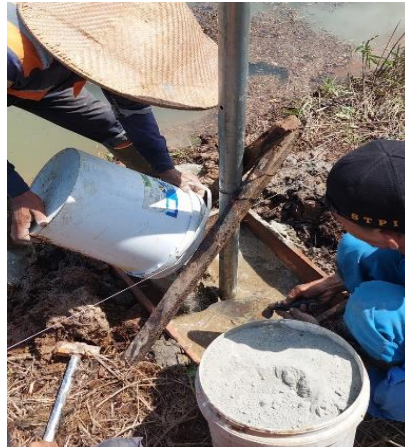
Gambar 4. 22 Pekerjaan Pemasangan Tiang Pagar dan Pengecoran Pondasi Setempat Sumber : Dokumentasi Pribadi, Tahun 2024
