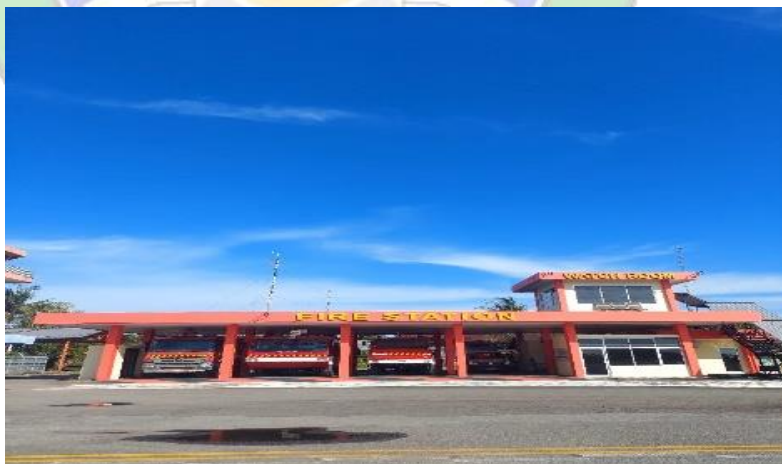
Gambar 4. 8 Gedung PKP-PK Bandar Udara Juwata Tarakan Sumber :Dokumentasi Pribadi, Tahun 2024
