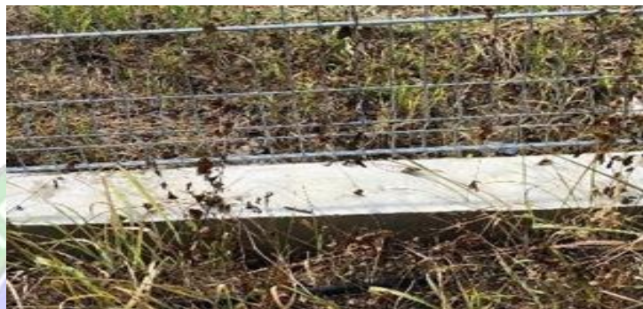
Gambar 4. 23 Pekerjaan Pasangan Batu Kali Sumber : Dokumentasi Pribadi, Tahun 2024
