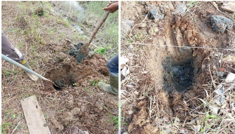
Gambar 4. 20 Pekerjaan Galian Tanah Untuk Pondasi Sumber : Dokumentasi Pribadi, Tahun 2024
