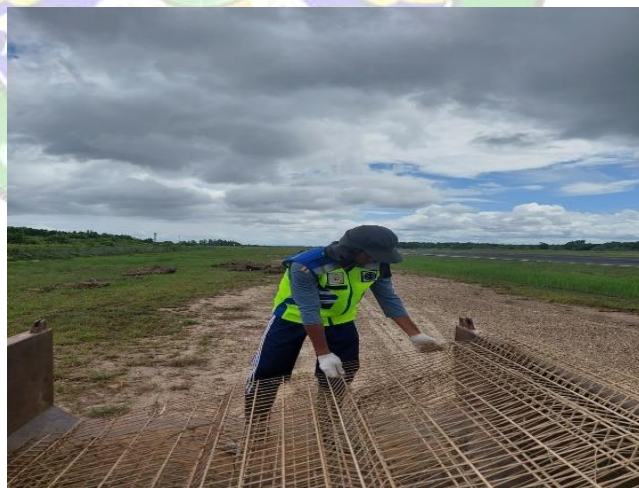
Gambar 4. 18 Pembersihan Lokasi Pemasangan Pagar Sumber : Dokumentasi Pribadi, Tahun 2024
