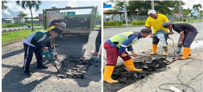
Gambar 4. 28 Pembongkaran Titik Kerusakan Sumber : Dokumentasi Pribadi, Tahun 2024
