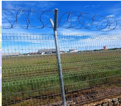
Gambar 4. 25 Pemasangan Kawat Duri Sumber : Dokumentasi Pribadi, Tahun 2024
