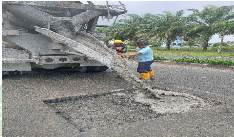
Gambar 4. 30 Penuangan Campuran Beton Sumber : Dokumentasi Pribadi, Tahun 2024
