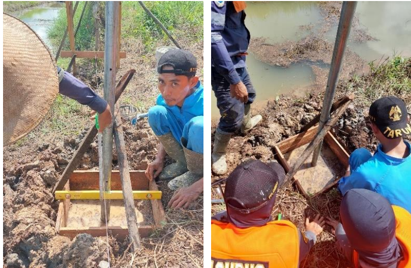
Gambar 4. 21 Pekerjaan Bekisting Sumber : Dokumentasi Pribadi, Tahun 2024
