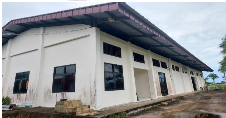
Gambar 4. 14 Gedung Power House Sumber : Dokumentasi Pribadi, Tahun 2024
