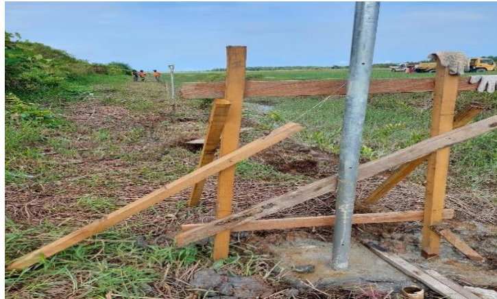
Gambar 4. 19 Pekerjaan Bouwplank Sumber : Dokumentasi Pribadi, Tahun 2024
