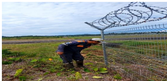
Gambar 4. 24 Pemasangan Pagar BRC Sumber : Dokumentasi Pribadi, Tahun 2024
