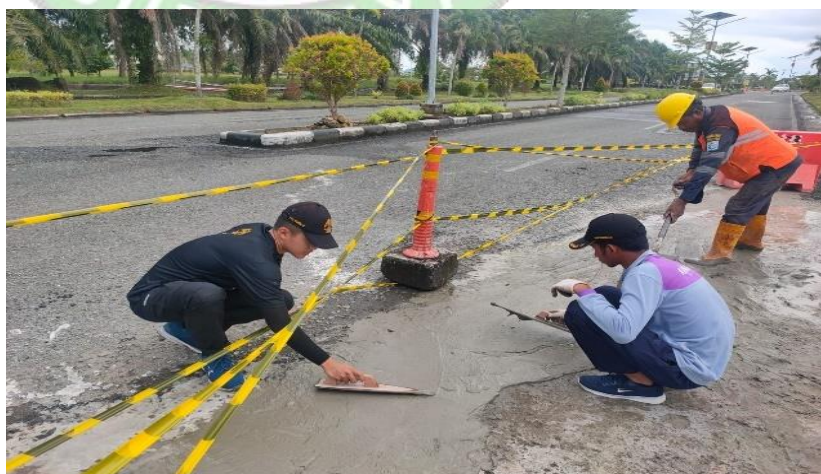
Gambar 4. 31 Perataan Permukaan Sumber : Dokumentasi Pribadi, Tahun 2024
