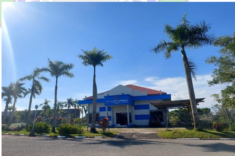
Gambar 4. 12 Gedung Keamanan Bandar Udara Juwata Tarakan Sumber : Dokumentasi Pribadi, Tahun 2024
