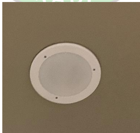
Gambar 3. 10 Speaker untuk Automatic Anouce System
