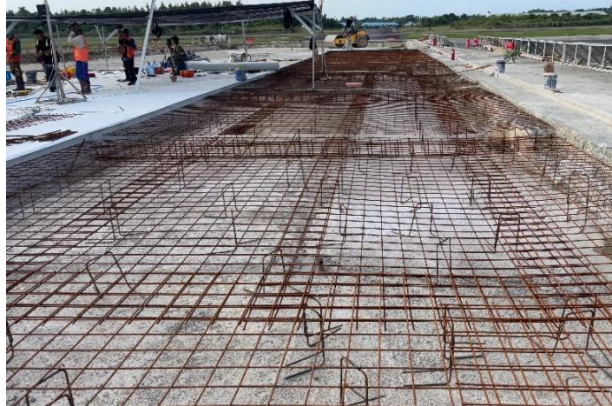
Gambar 4. 4 Pemasangan wiremesh dan tie bars (Sumber : Dokumentasi Penulis)
