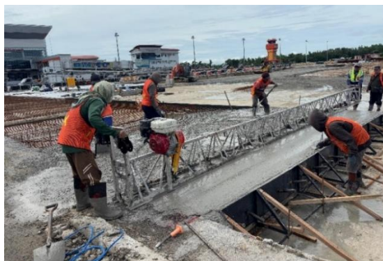
Gambar 4. 6 Pekerjaan saat cor diratakan menggunakan concrete truss screed (Sumber : Dokumentasi Penulis)
