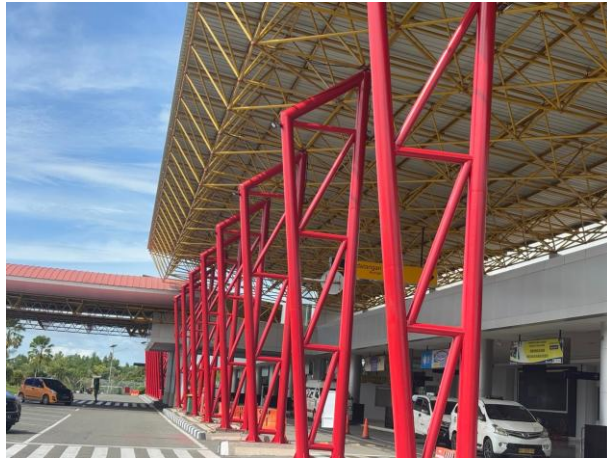
Gambar 4. 13 Hasil pekerjaan pengecatan tiang kanopi (Sumber : Dokumentasi penulis)
