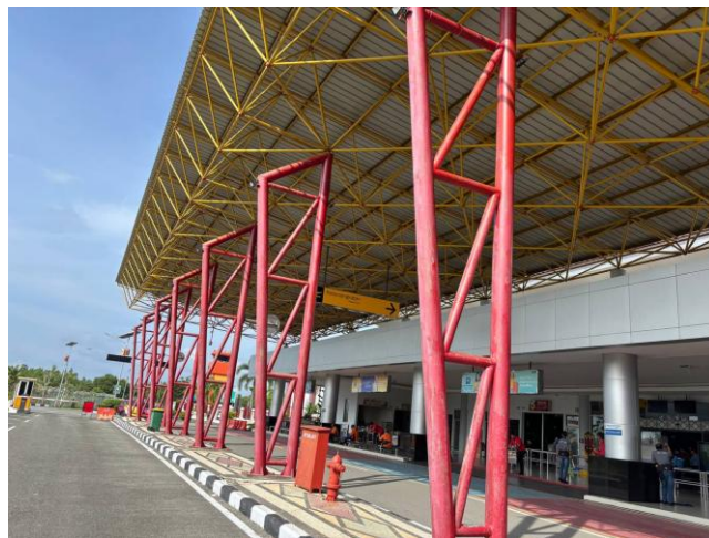
Gambar 4. 2 Tiang kanopi terminal penumpang sebelum pengecatan (Sumber : Dokumentasi Penulis)
