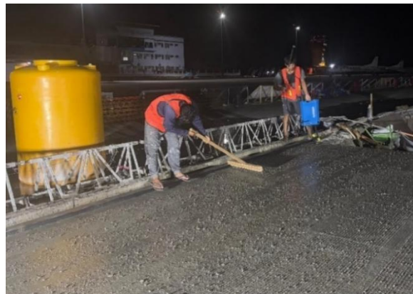
Gambar 4. 7 Pekerjaan curing beton dan grooving (pembuatan alur) (Sumber : Dokumentasi Penulis)
