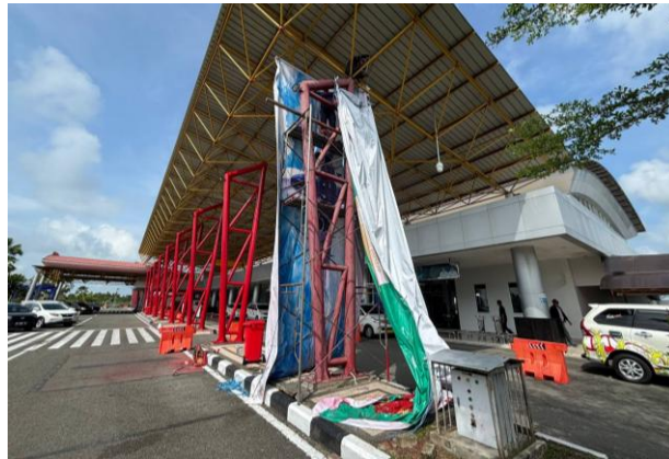
Gambar 4. 10 Pemasangan scaffolding dan terpal (Sumber : Dokumentasi penulis)
