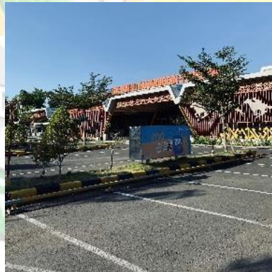
Gambar 4.9 Parking Area ( Sumber : Dokumentasi Pribadi, 2024 )
