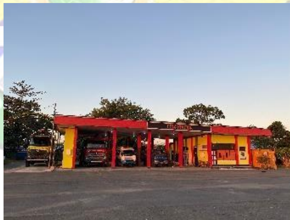
Gambar 4.4 Gedung PKP-PK ( Sumber : Dokumentasi Pribadi, 2024 )
