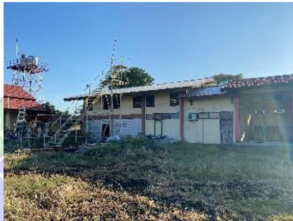
Gambar 4.7 Gedung Power House ( Sumber : Dokumentasi Pribadi, 2024 )
