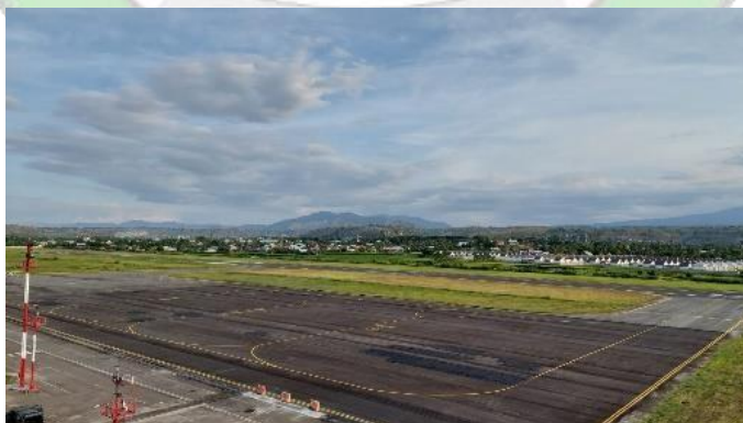
Gambar 4.24 Hasil Pengecatan Parking Stand ( Sumber : Dokumentasi Pribadi, 2024 )
