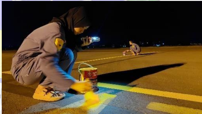
Gambar 4.22 Pengecatan Parking Stand Tumpang Tindih/Tidak Kritis ( Sumber : Dokumentasi Pribadi, 2024 )
