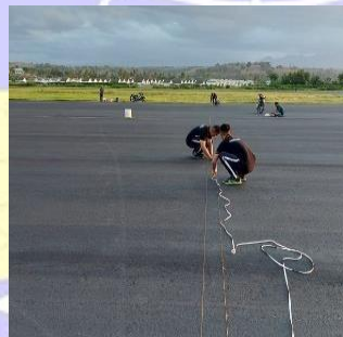
Gambar 4.18 Pengecatan Marka Parking Stand Apron ( Sumber : Dokumentasi Pribadi, 2024 )
