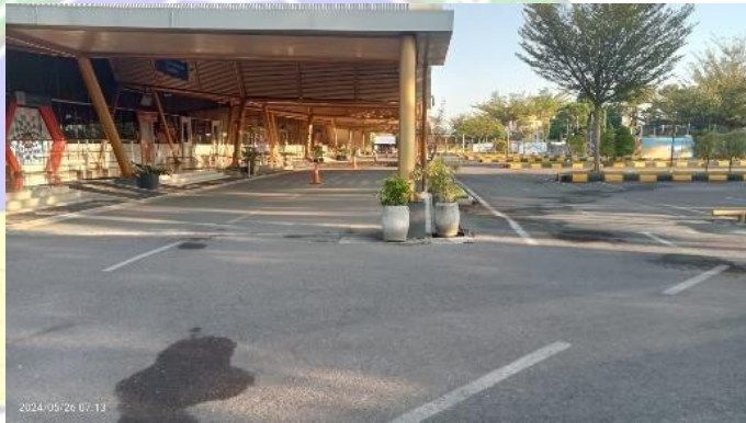
Gambar 4.25 Lokasi Pekerjaan Perataan Permukaan Drop Zone ( Sumber : Dokumentasi Pribadi, 2024 )
