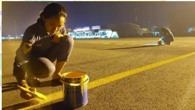
Gambar 4.20 Pengecatan Lead-in Lead-out ( Sumber : Dokumentasi Pribadi, 2024 )
