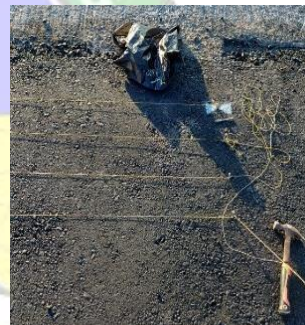
Gambar 4.18 Pengecatan Marka Parking Stand Apron ( Sumber : Dokumentasi Pribadi, 2024 )
