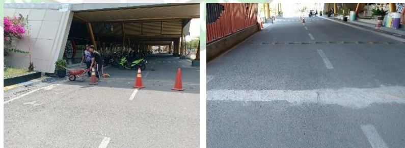
Gambar 4.28 Hasil Perataan Permukaan Drop Zone ( Sumber : Dokumentasi Pribadi, 2024 )
