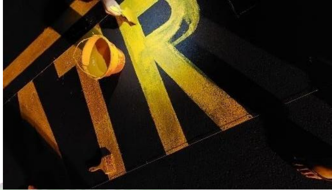
Gambar 4.21 Pengecatan Aircraft Stand ( Sumber : Dokumentasi Pribadi, 2024 )
