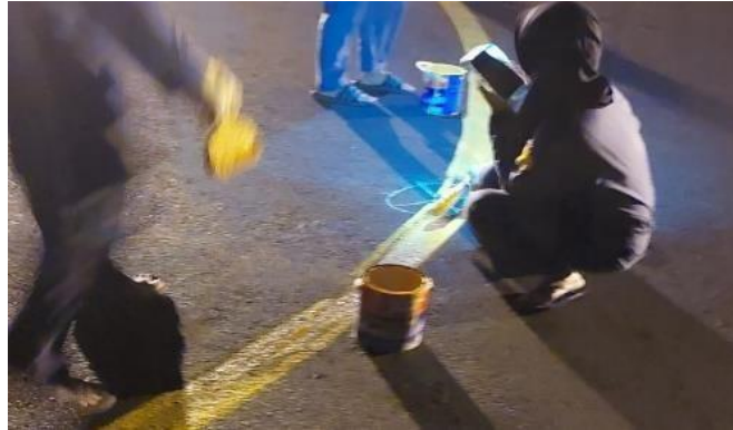
Gambar 4.23 Pengecatan Pilot Stop Line ( Sumber : Dokumentasi Pribadi, 2024 )
