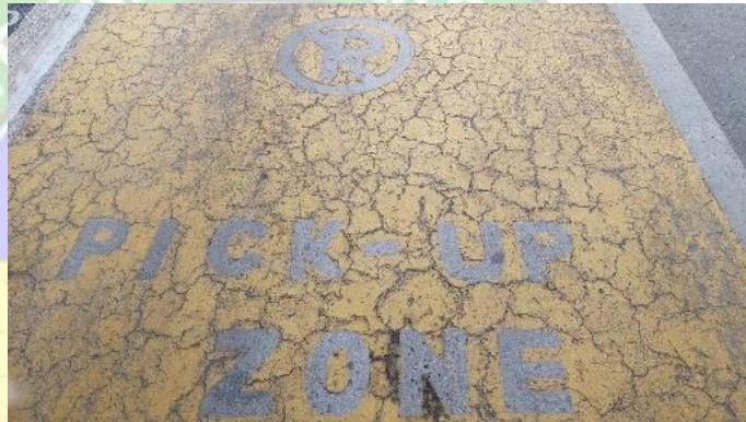
Gambar 4.15 Penglupasan Cat Marka Pick-up Zone ( Sumber : Dokumentasi Pribadi, 2024 )
