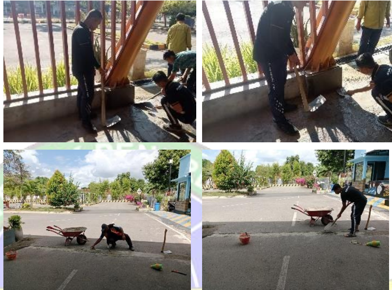
Gambar 4.27 Pekerjaan perataan permukaan drop zone ( Sumber : Dokumentasi Pribadi, 2024 )
