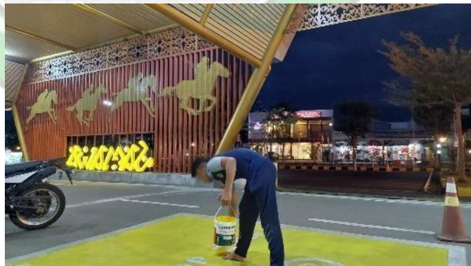
Gambar 4.33 Pengecatan Marka Drop Zone ( Sumber : Dokumentasi Pribadi, 2024 )
