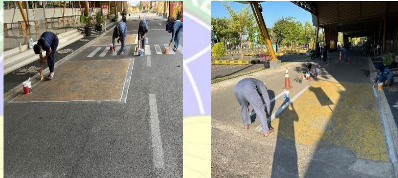
Gambar 4.32 Pengecatan Zebra Cross , Centre Line , dan Side Stripe ( Sumber : Dokumentasi Pribadi, 2024 )
