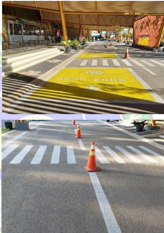
Gambar 4.34 Hasil Pengecatan Drop Zone ( Sumber : Dokumentasi Pribadi, 2024 )
