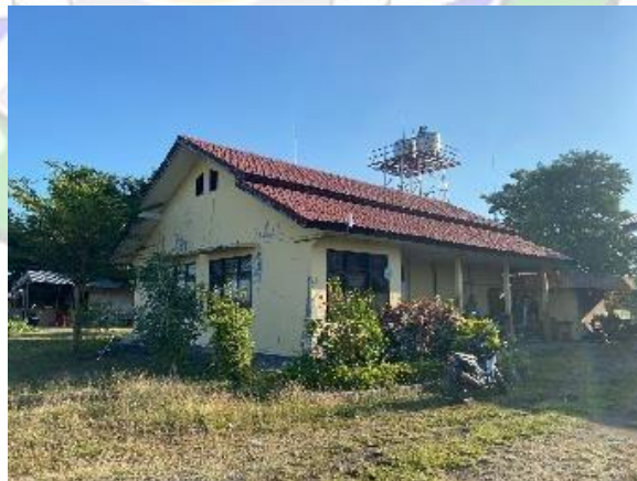
Gambar 4.6 Gedung CCR ( Sumber : Dokumentasi Pribadi, 2024 )
