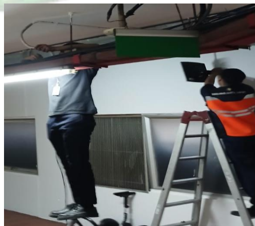
Penggantian kabel pada slave clock di T1B
