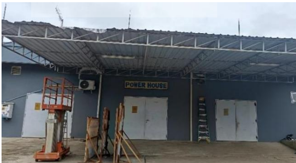
Gambar 2.16 Power House Bandar Udara Kalimantan Sumber:Dokumentasi pribadi
