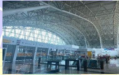
Gambar 2.3 Gedung Terminal Bandara
