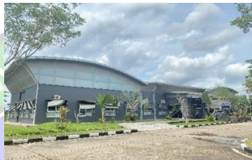
Gambar 2.4 Gedung Administrasi Bandara
