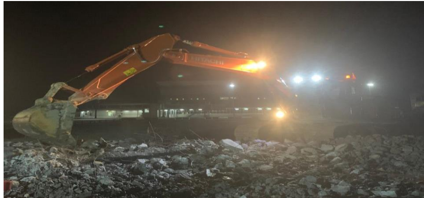
Gambar 4. 14 Pekerjaan Galian Keras Rigid Pavement dan Pembuangan Sumber : Dokumentasi pribadi, 2024
