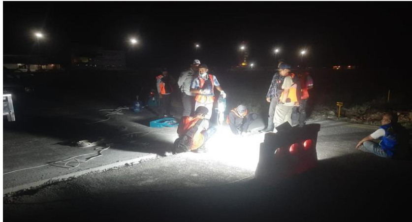
Gambar 4. 10 Pekerjaan Pembongkaran Menggunakan Jackhammer Sumber : Dokumentasi pribadi, 2024
