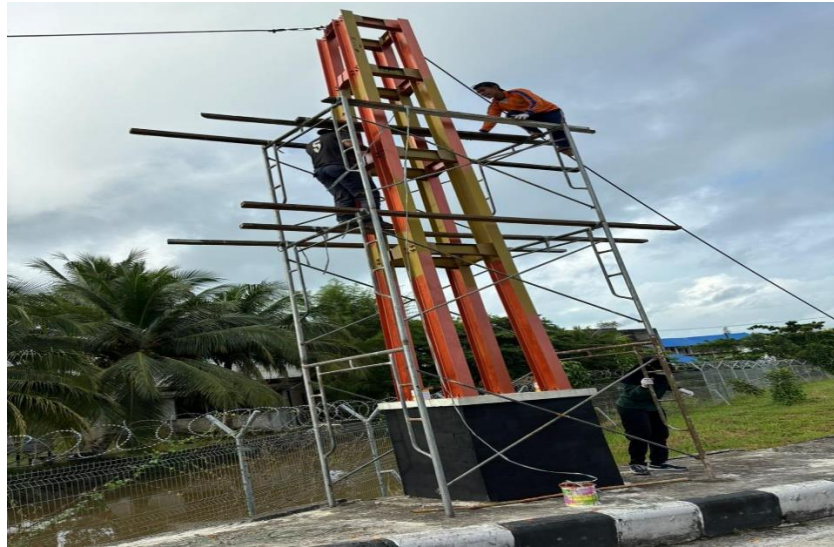
Gambar 4. 21 Pekerjaan Pengecatan Sumber : Dokumentasi pribadi, 2024
