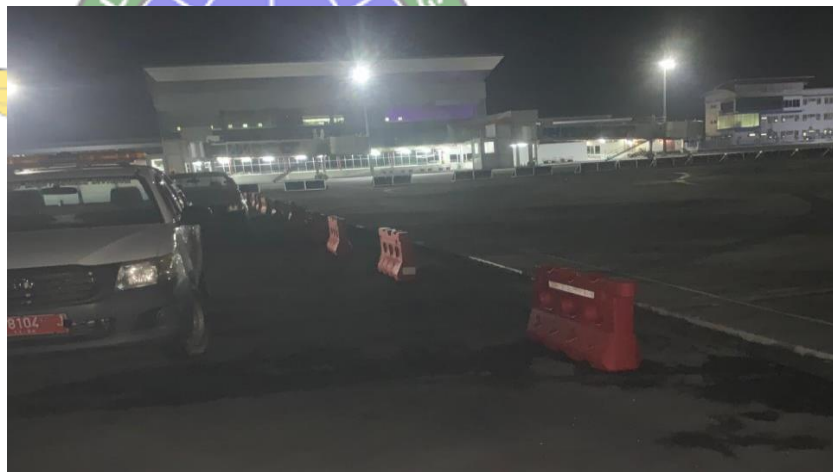
Gambar 4. 7 Pemasangan Barrier Sumber : Dokumentasi pribadi, 2024
