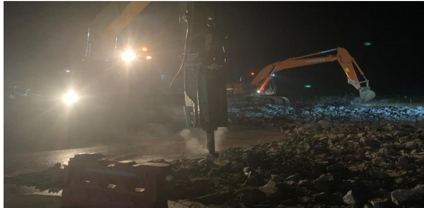
Gambar 4. 12 Pembongkaran Rigid Pavement Menggunakan Breaker Excavator
