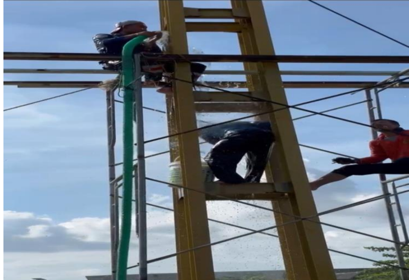
Gambar 4. 19 Pekerjaan Penyemprotan Sumber : Dokumentasi pribadi, 2024
