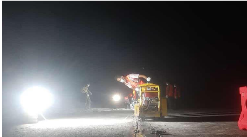
Gambar 4. 8 Pekerjaan Cutting Rigid Pavement Sumber : Dokumentasi pribadi, 2024
