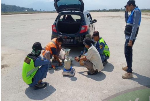
Pengujian sandcone pada subgrade apron
