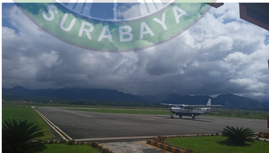
Gambar 4. 11 Apron (Sumber: Dokumentasi Penulis, 2024)
