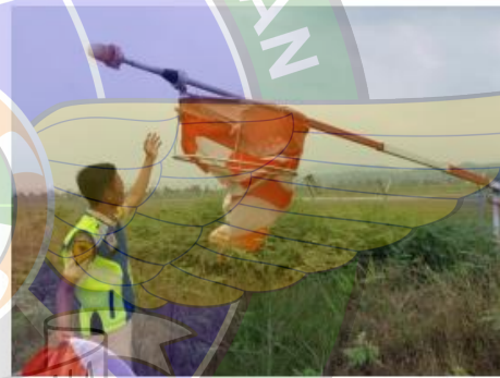
Penggantian windsock dengan yang baru
