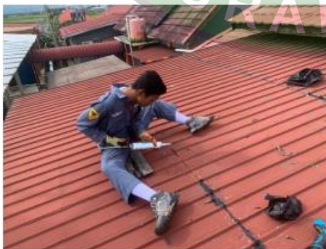
Perbaikan kebocoran atap pada ruang material dengan sealant
