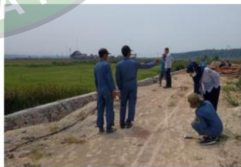
Pengukuran KKOP terhadap lokasi yang akan dibangun
