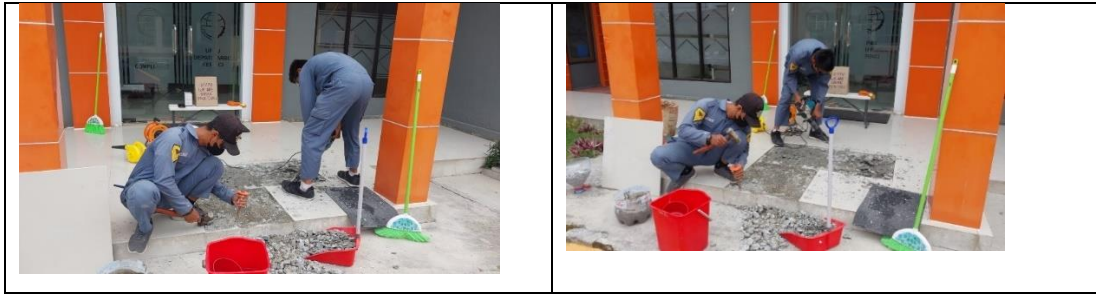
Gambar 4.20 Pembuatan Lantai Kerja (Sumber: Dokumentasi Penulis, 2024)
