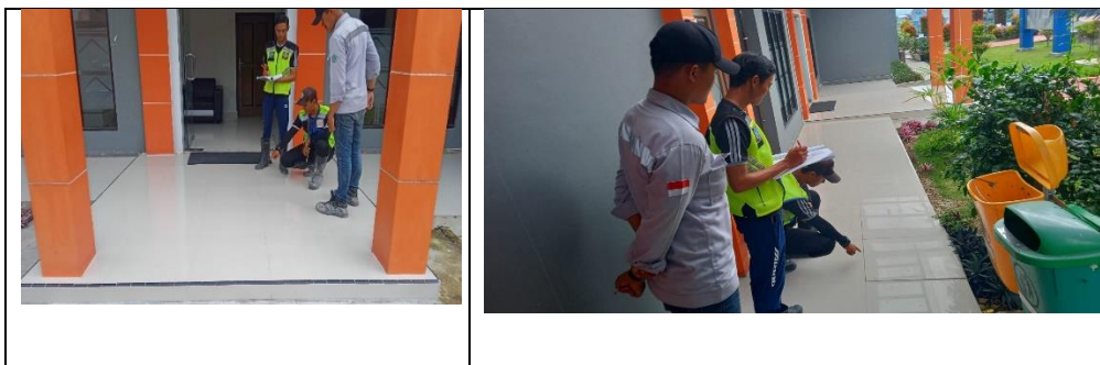
Gambar 4. 15 Peninjauan Lokasi Perbaikan Lantai Keramik (Sumber: Dokumentasi Penulis, 2024)
