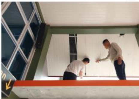
Perbaikan plafon pada terminal kedatangan
