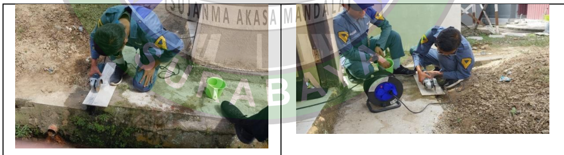
Gambar 4.22 Pemotongan Keramik granit (Sumber: Dokumentasi Penulis, 2024)
