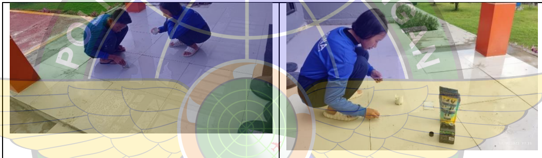
Gambar 4.24 Peletakan nut Keramik (Sumber: Dokumentasi Penulis, 2024)
