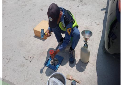
Pengujian sandcone pada subgrade apron
