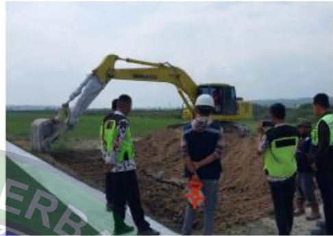
Peninjauan proyek pembuatan taxiway baru
