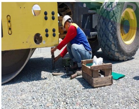
Pengujian CBR pada subbase apron
