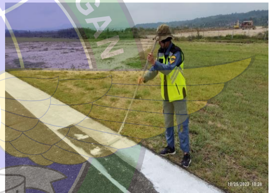
Melakukan pengecatan marka landasan
