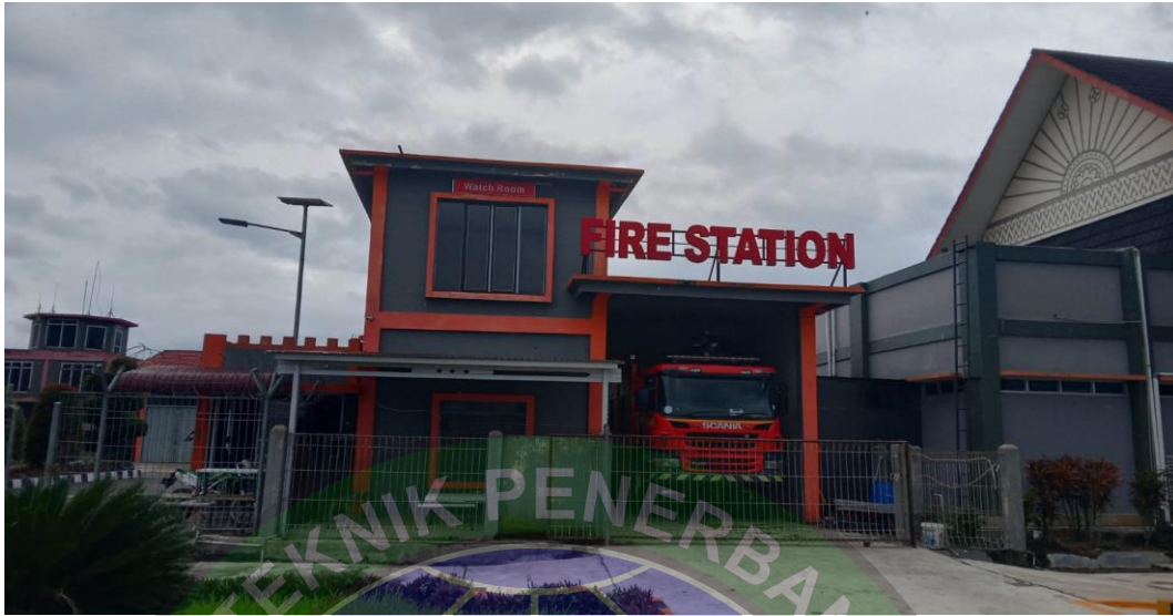
Gambar 4. 3 Gedung PKP-PK Bandar Udara Depati Parbo (Sumber: Dokumentasi Penulis, 2024)
