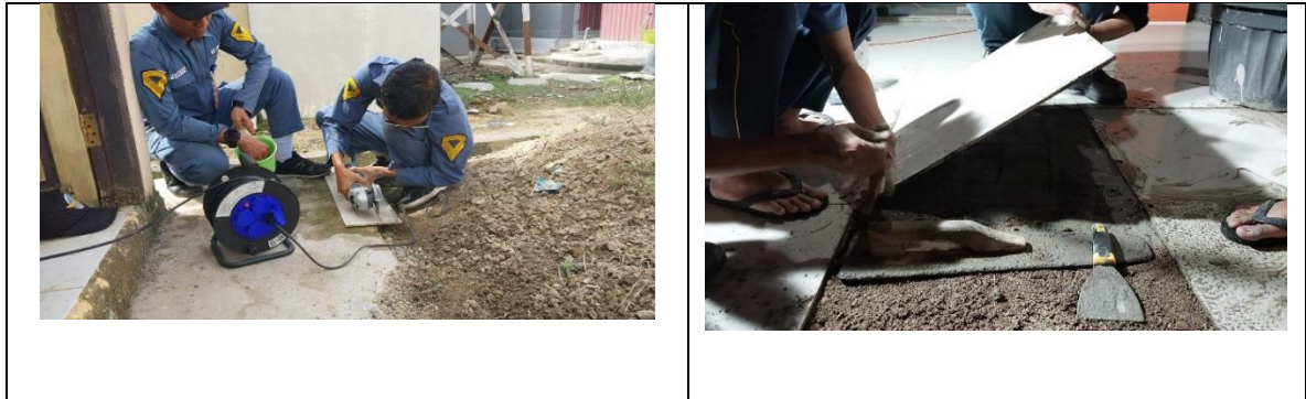
Gambar 4.23 Peletakan Keramik (Sumber: Dokumentasi Penulis, 2024)
