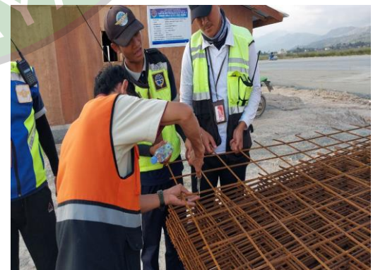
Pemeriksaan diameter besi tulangan
