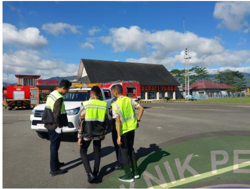
Meninjau kerusakan apron akibat helikopter
