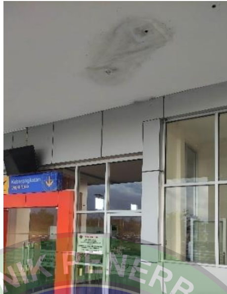
Gambar 4. 30 Proses Pencarian titik lubang dan kerusakan
