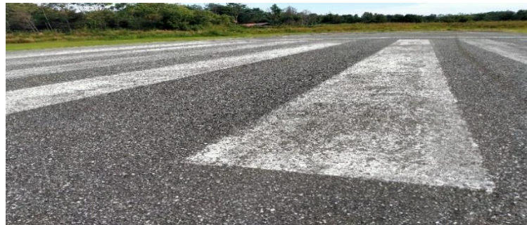
Gambar 4. 16 Marka Runway yang Memudar
