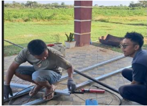
Gambar 4. 24 Proses pengelasan besi holo
