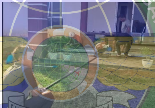
Gambar 4. 23 Proses pemotongan besi holo
