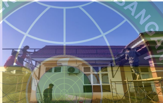
Gambar 4. 25 Proses pemasangan besi holo dan pemasangan atap spandek
